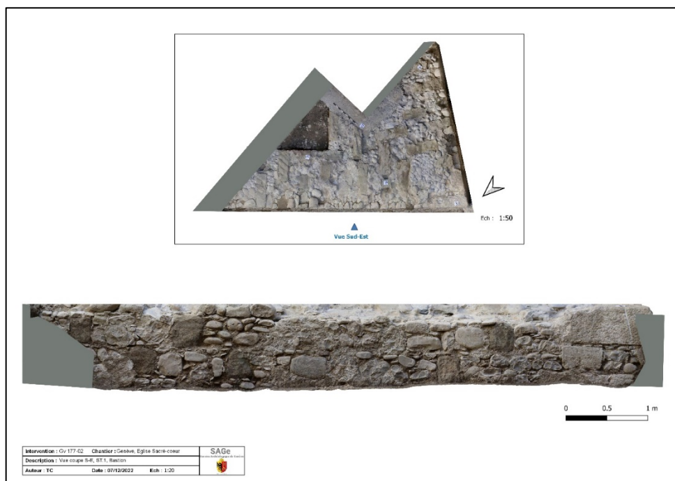
FIG 11 Photogrammétries zénithale et de la coupe de la demi-lune de Neuve (face nord-est).
