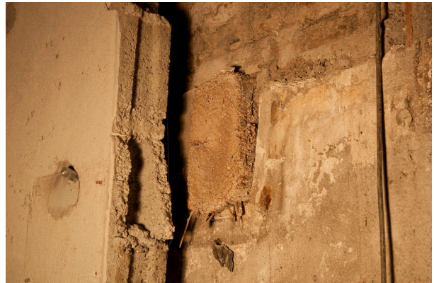
Figure 25. Rez-de-chaussée. Mitoyen nord. Tête de solive sciée.
