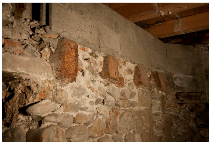
Figure 10. Poutraison du plancher du 1 er étage. Phase II.
