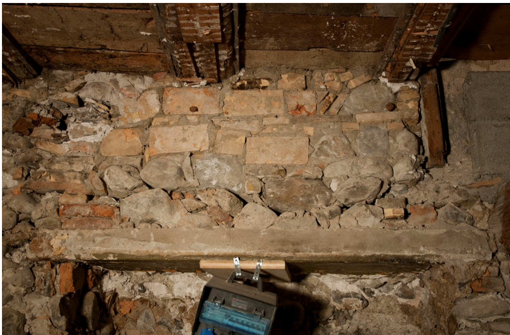
Figure 20. Rez-de-chaussée. Solives surélevées, installées sur un appareil de brique et gros galets (US 028).
