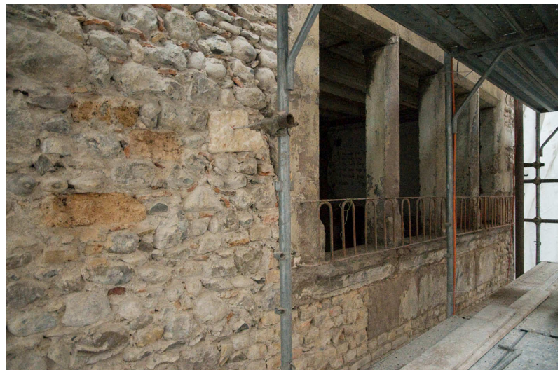
Figure 33. Fenêtres à meneaux chanfreinés du 3 e étage.
