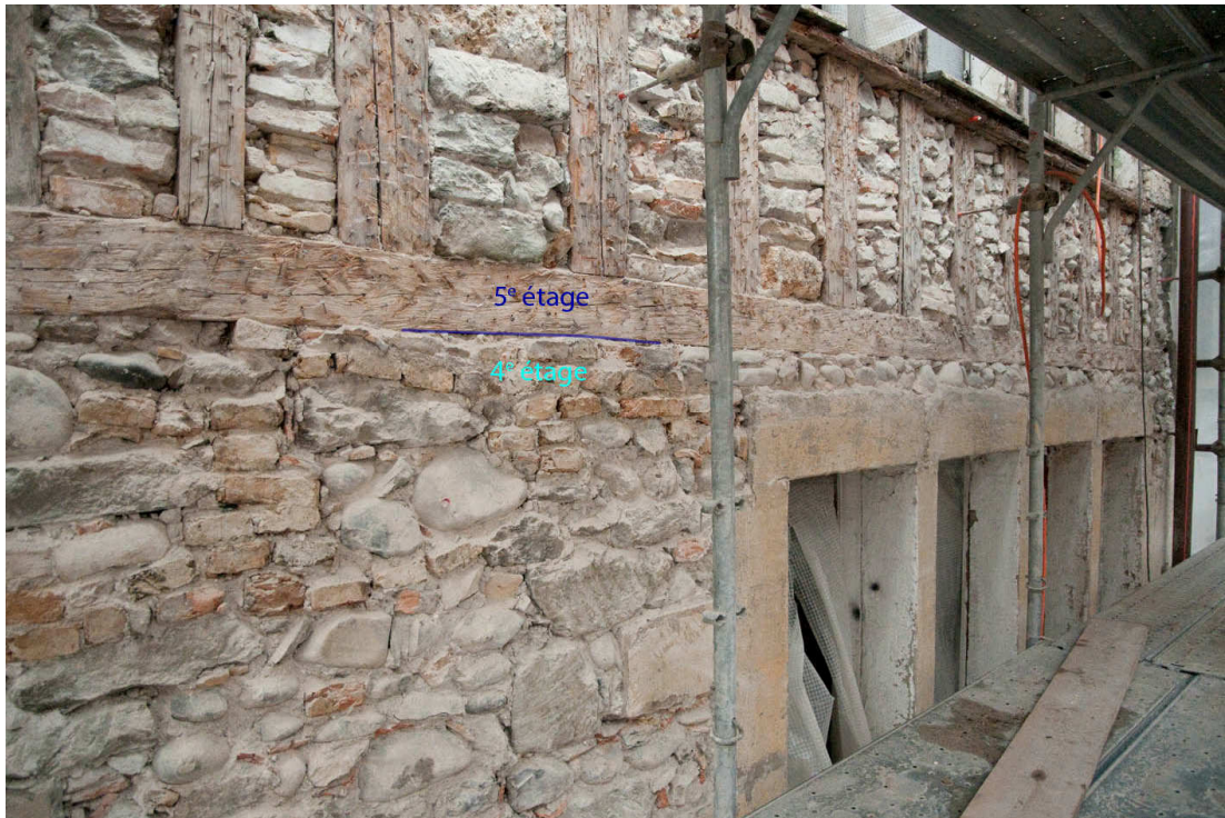
Figure 34. Fenêtres à meneaux du 4 e étage et façade en colombage du 5 e étage.
