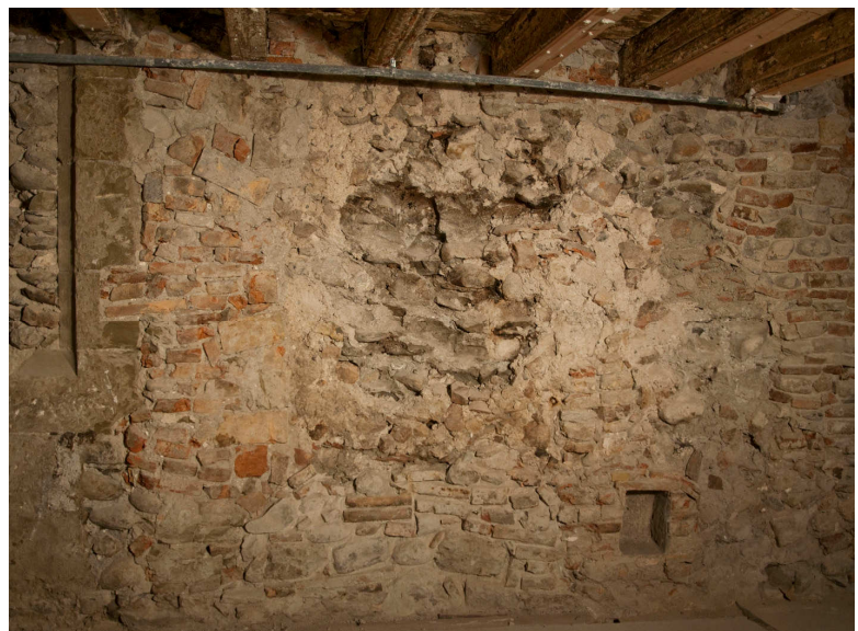
Figure 11. 1 er étage. Maçonnerie d'origine noircie par la suie de la probable cheminée.
