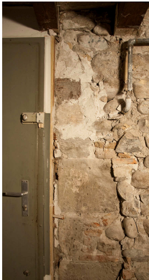
Figure 16. 1 er étage. Rehaussement de la porte d'origine.
