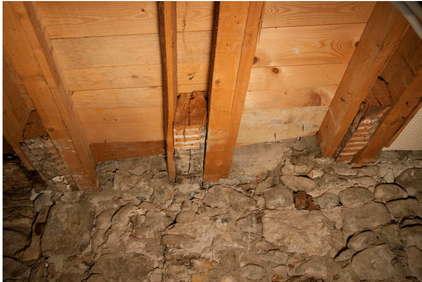
Figure 22. Rez-de-chaussée. Renfort et doublage des poutres du XVIII e .
