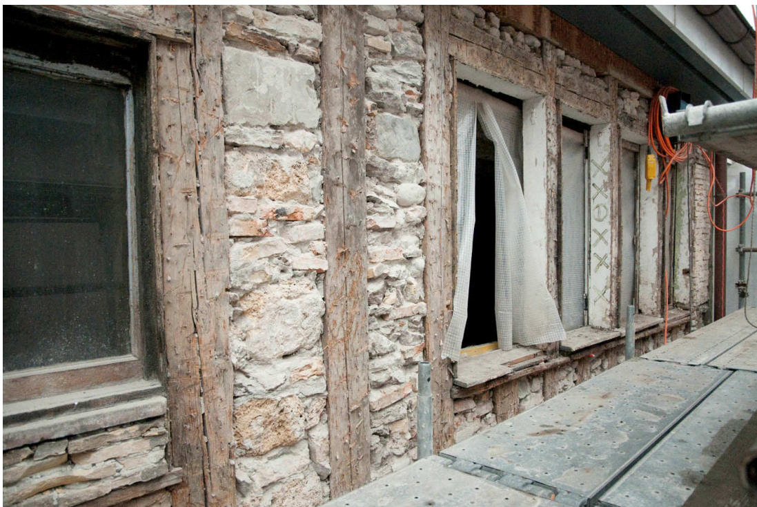
Figure 35. Fenêtres à meneaux et façade en colombage du 5 e étage.
