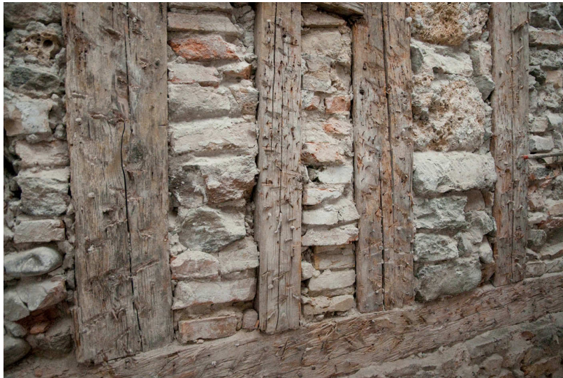
Figure 36. Détail des poteaux et hourdis de la façade en colombage du 5 e étage.
