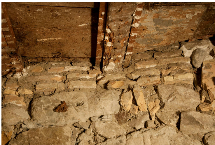
Figure 21. Rez-de-chaussée. Recalage des poutres au moyen de briques.
