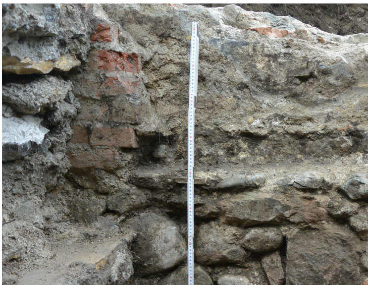
Figure 22. Doublage en brique (US22) de l'élévation du mur ST 2.
