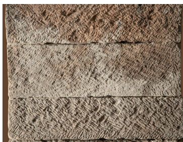
Fig.14 Bât.A: V14, détail des blocs en molasse brettés
