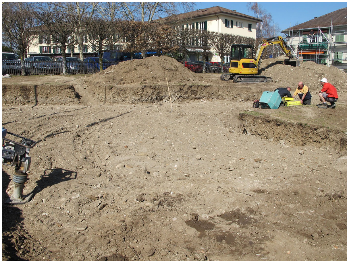
Remblayage de la surface des sondages 3, 4 et 5.
