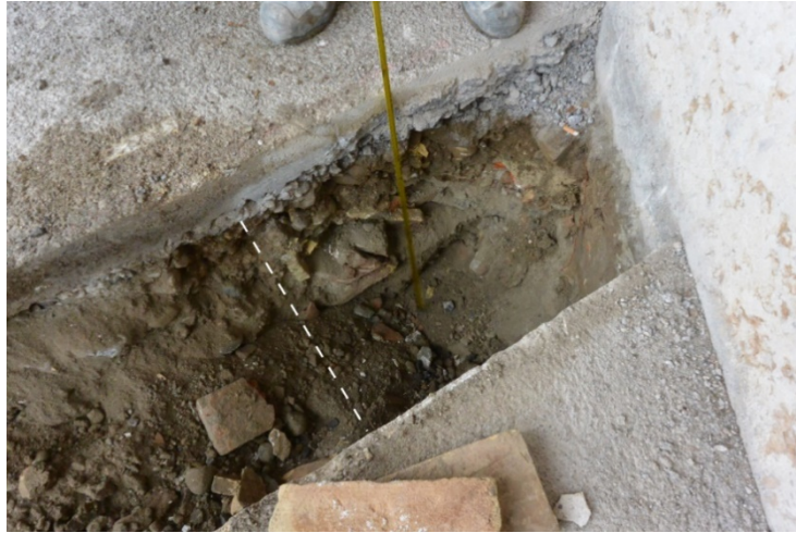
Figure 5. Église Sainte-Croix : tranchée de fondation du mur ouest, remplie d'un blocage de gros galets et de briques.
