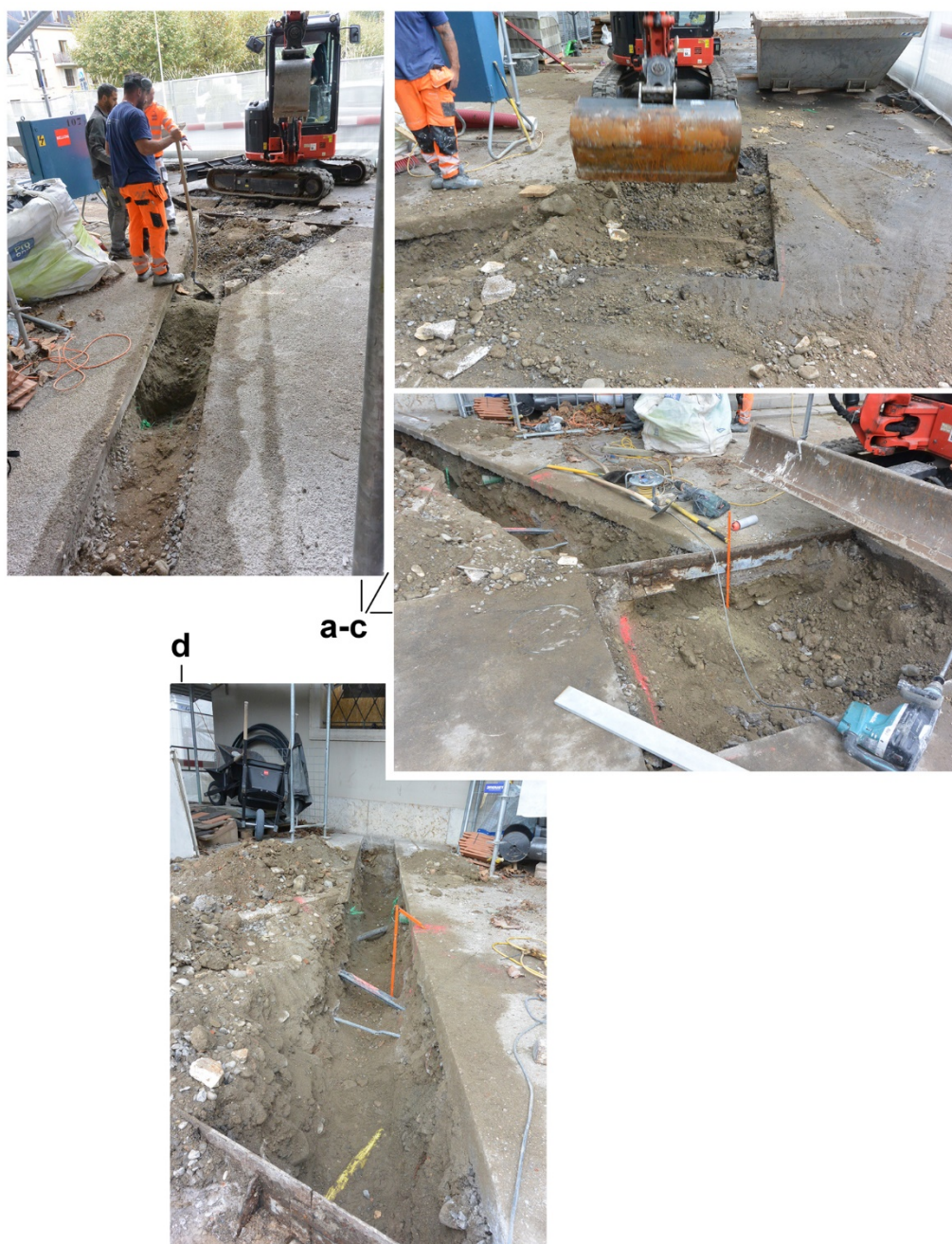
Figure 4. Église Sainte-Croix, travaux de rénovation des réseaux SIG. a-c : tranchée n° 1 en cours de décapage, d : niveau de fond.
