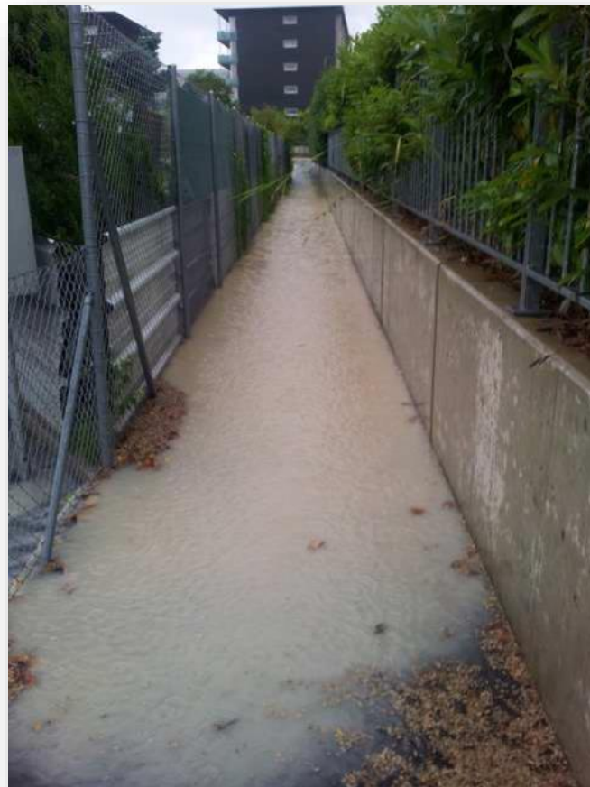
Refoulement du réseau d'assainissement
