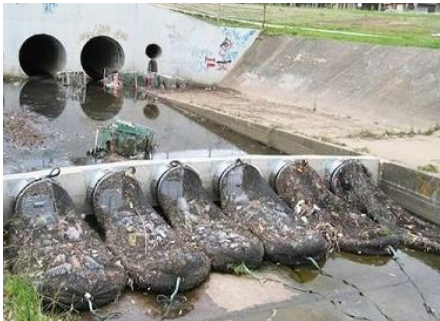
Figure 43. Exemple d'implémentation filets attrape-déchets.
