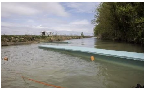
Figure 39. Exemple d'implémentation Blue Barriers.
