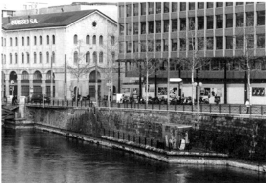
Figure 272 Epaule du bastion de Hollande baignée par les eaux du Rhône, état en 2007 (IMAHGe). Cet ouvrage, au- jourd'hui absorbé par le quai de la Poste, supportait un talus de terre de près de 4 m de hauteur, ce qui corres- pond de nos jours au niveau de la rue. A gauche, on remarque l'ancien marché couvert de Bel-Air (Crédit Lyonnais) construit en 1830. – Texte p. 283.
