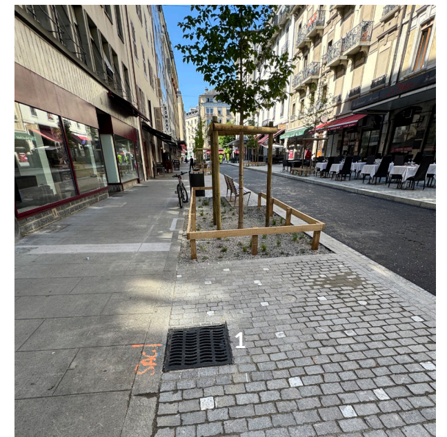
Chambre d'aération et de diffusion
