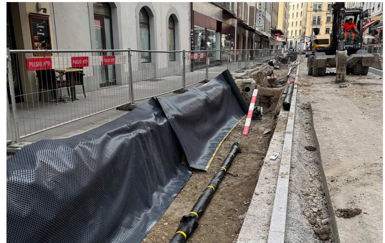
Compactage du fond de forme penté vers drain + dela MS latéral
