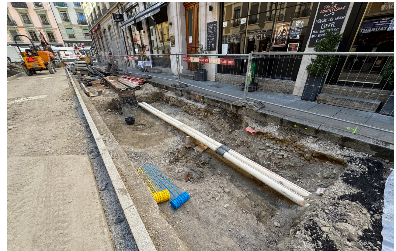
Protection, tubage et signalisation des réseaux
