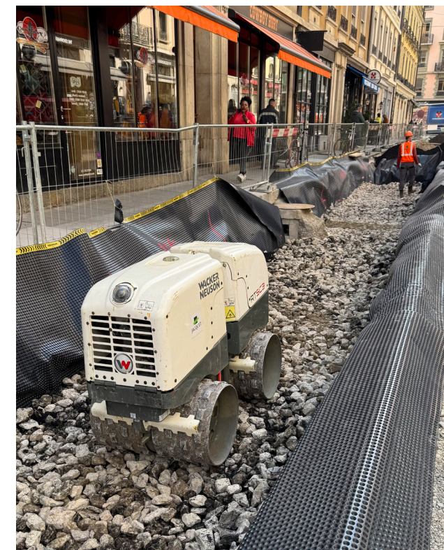
4- Compactage au pied de mouton (non vibré)
