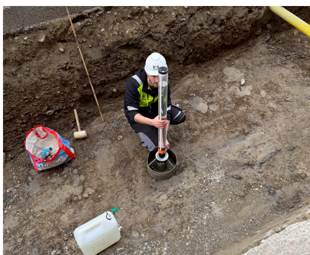
Test d'infiltration sur fond de forme
