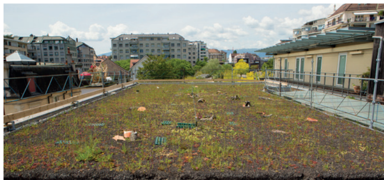
Toiture végétalisée avec un mélange "maison" de substrats d'origine locale (Toitures de Saint-Jean)
