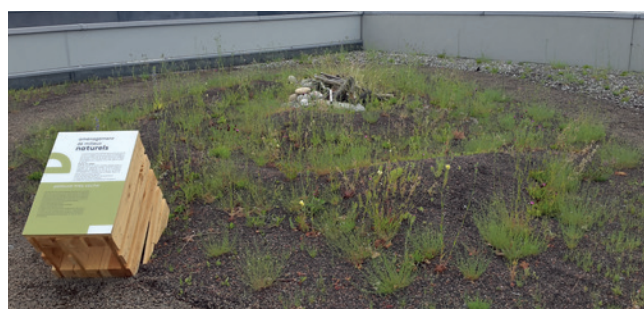
Toiture avec substrat épandu de façon hétérogène et composée de plusieurs types de substrat (Toiture Nature-Echo Onex)
