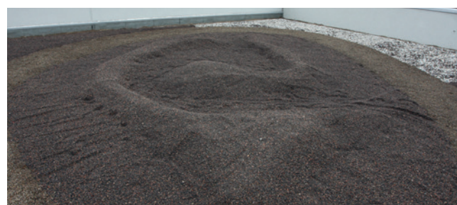
Mise en place d'herbes à semences sur une toiture existante (Toitures de Saint-Jean)
