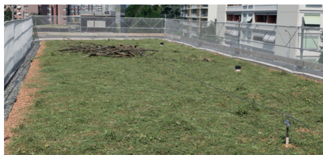
Mise en place d'herbes à semences sur une toiture existante (Toitures de Saint-Jean)
