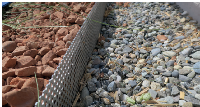
Bande de drainage en graviers
