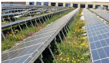
Toiture biosolaire (Palais de Beaulieu Lausanne)
