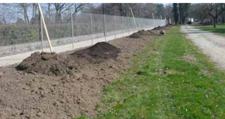
Préparation du sol, sur toute la largeur d'implantation, avant la plantation d'une haie d'espèces indigènes.
