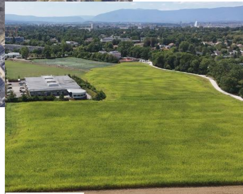
Vue de drone du futur site du Bioparc
