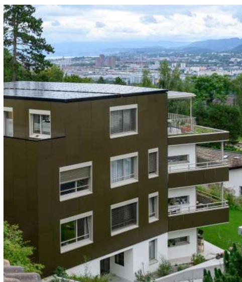
Bâtiment résidentiel à Zurich - Bureau Kämpfer für architektur : Modules photovoltaïques en verre utilisés comme matériau de façade et pour les parapets de balcons.
