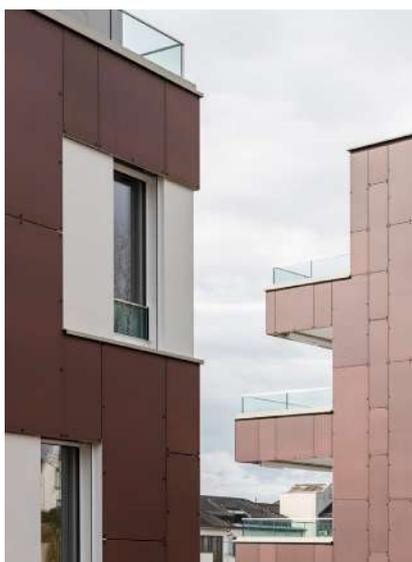
Lotissement neutre en CO<sub>2</sub> à Mannedorf - Bureau René Schmid : Utilisation de panneaux solaires Solaxess en façade. Les panneaux en façade combinés à des panneaux en toiture et deux éoliennes permettent d'assurer tous les besoins en électricité des résidents.
