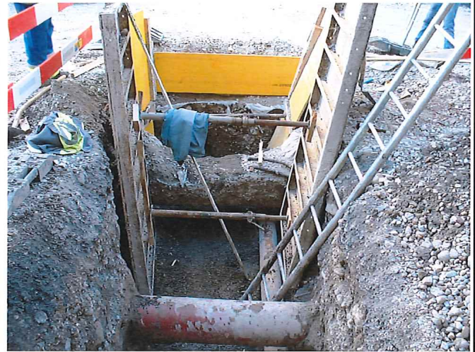
Raccordement EU au collecteur public
