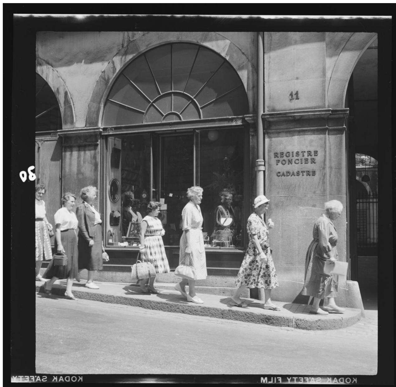
Devantures métalliques avec volets latéraux (fermés sur la devanture de gauche - vue partielle), rue de l'Hôtel-de-Ville 11.
