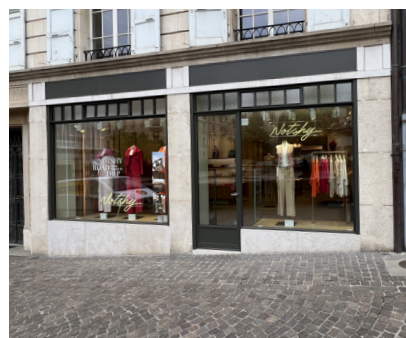
Après restitution Rue de la Fontaine 5, 2021
