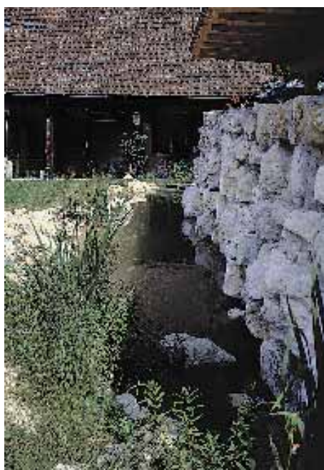
L'eau du toit du couvert à voitures s'écoule directement dans le petit biotope
