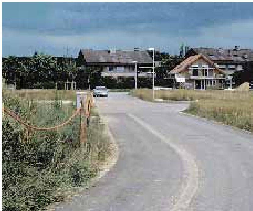
Caniveau à ciel ouvert au milieu de la route
