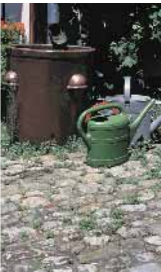
Citerne d'eau de pluie: utilisation de l'eau du toit pour l'arrosage
