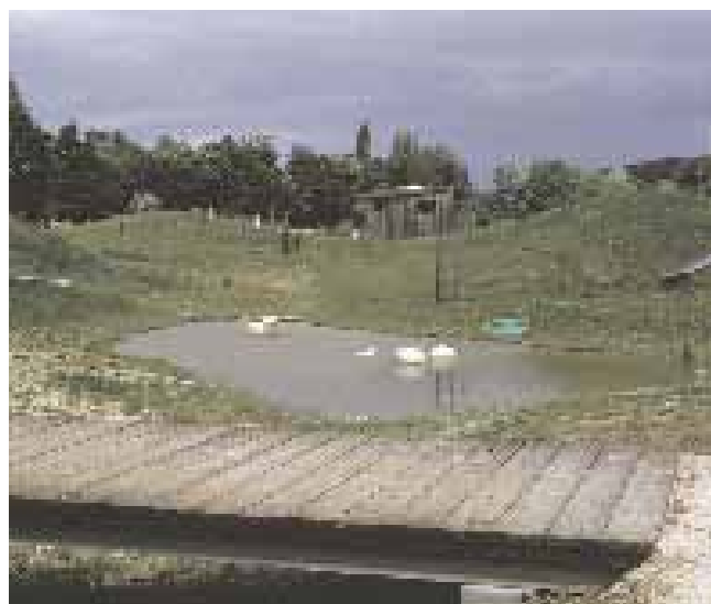
Bassin de rétention de la place de jeux
