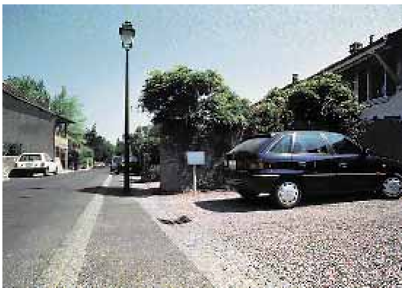
Aménagement de la route à l'aide de caniveaux pavés
