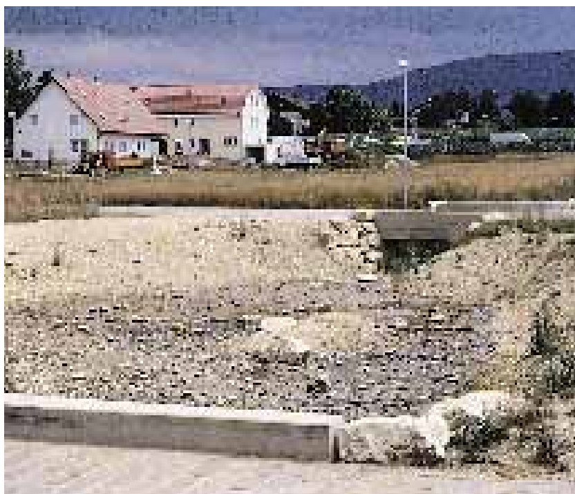
Bassin de rétention au milieu de la zone à bâtir
