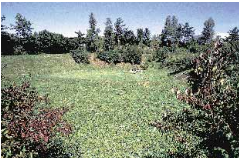
Bassin de rétention et de filtration
