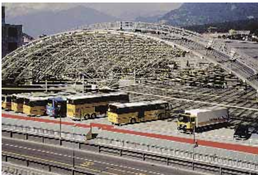
Toit de verre sur la gare postale
