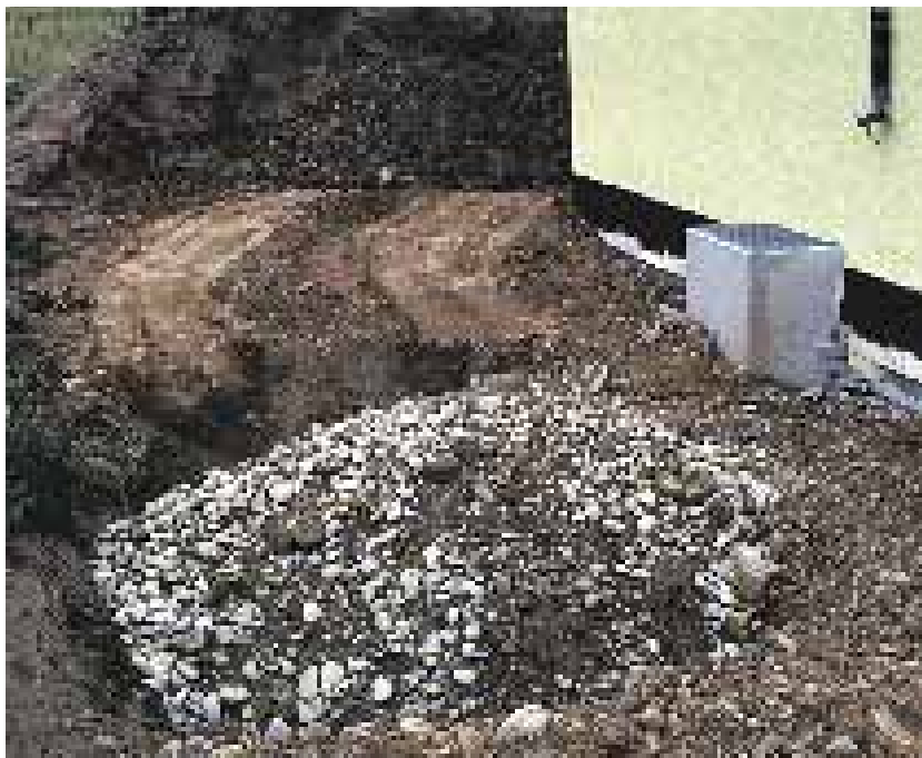
Création d'une dépression destinée à l'infiltration: nivellement du tout-venant
