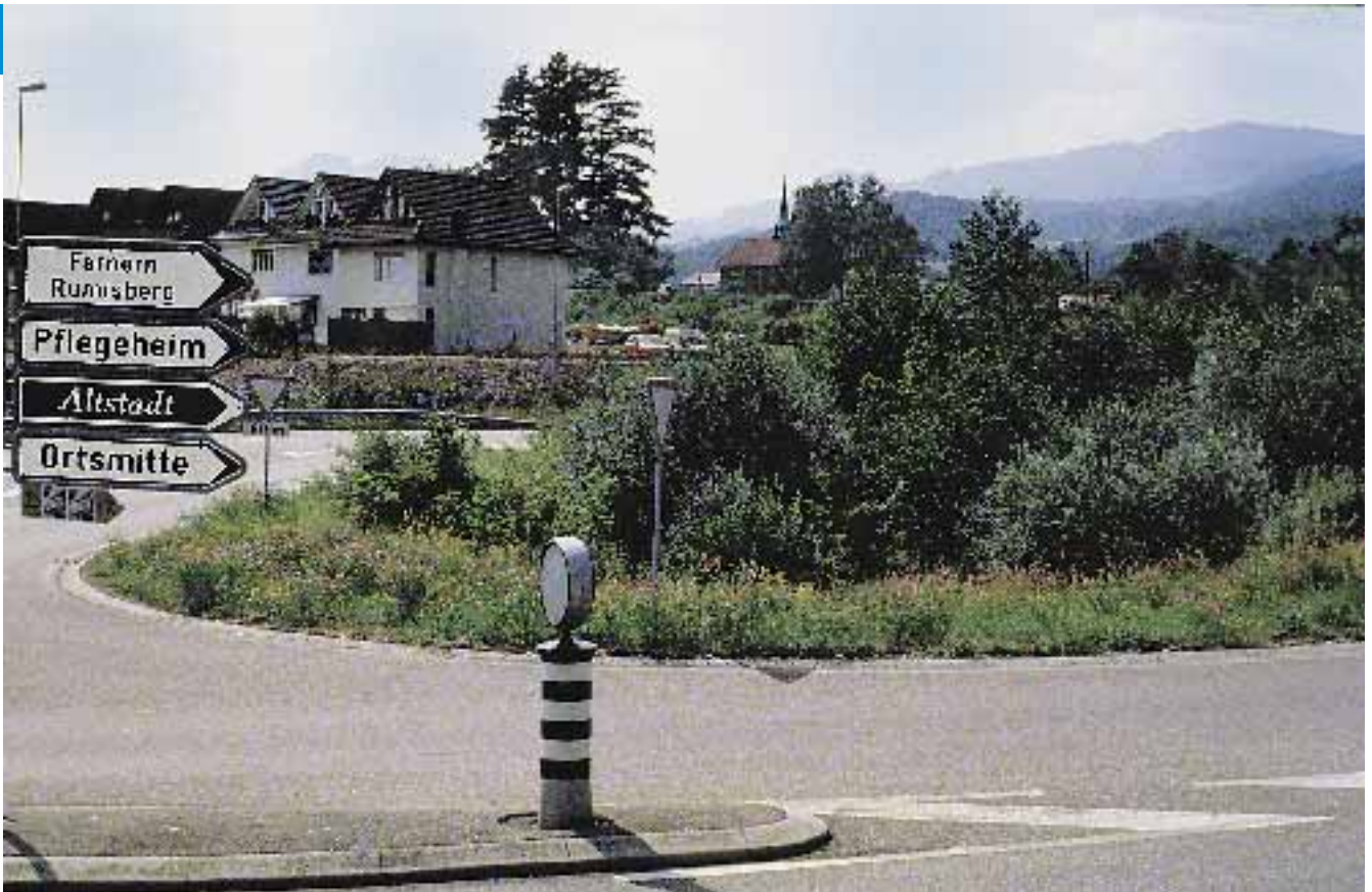
Bassin de rétention et d'infiltration au milieu du giratoire
