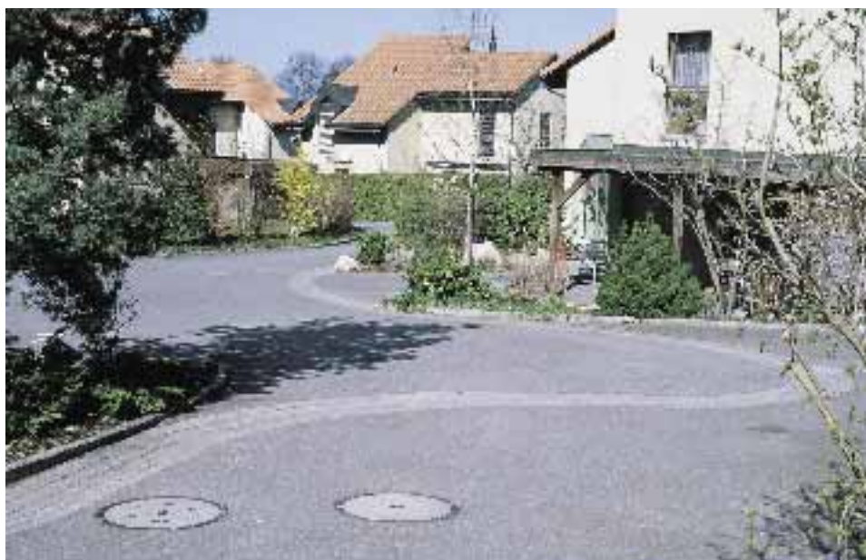
Caniveau d'écoulement comme élément d'aménagement de la route
