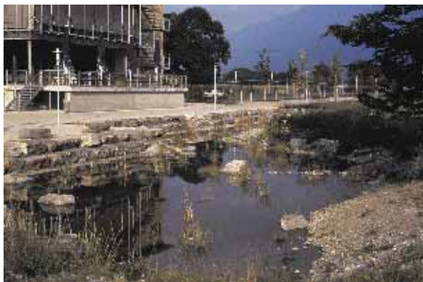
Bassin de rétention et d'infiltration avec des gradins
