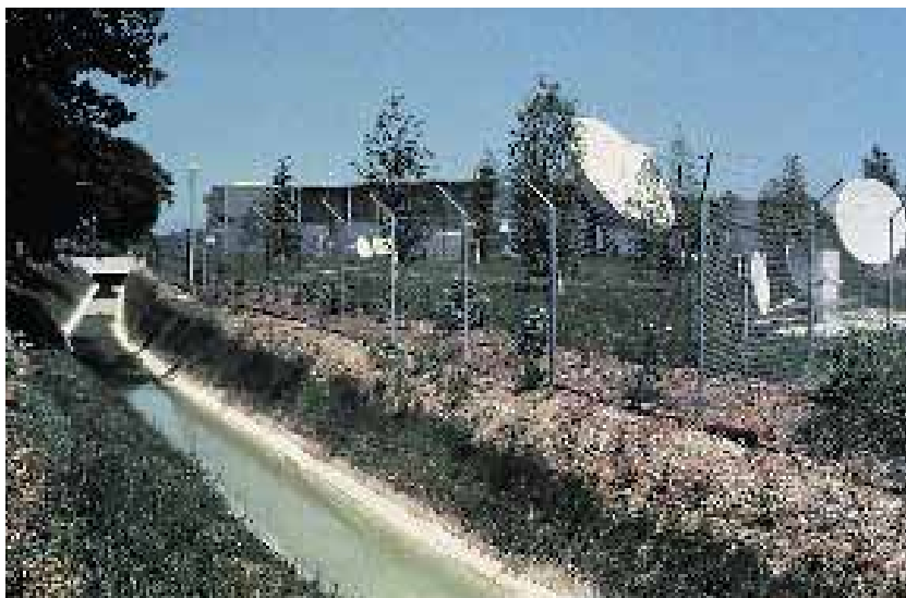
Canal de rétention
