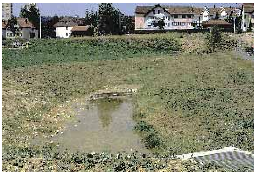
Bassin de rétention et d'infiltration recouvert d'humus
