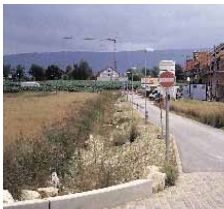
Fossé d'évacuation des eaux le long de la route pour les eaux des toits et des routes
