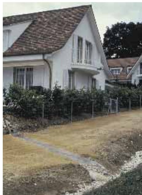
Le caniveau à ciel ouvert conduit l'eau des toits dans le fossé d'infiltration
