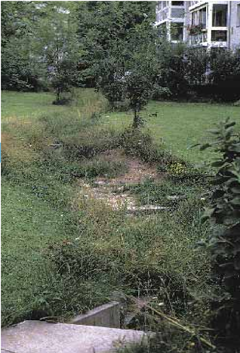
Caniveau à ciel ouvert évacuant l'eau de pluie à travers la zone d'habitation
