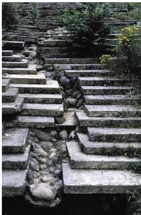
Prolongement du caniveau: d'anciennes balustrades recyclées soulignent la différence de niveau
