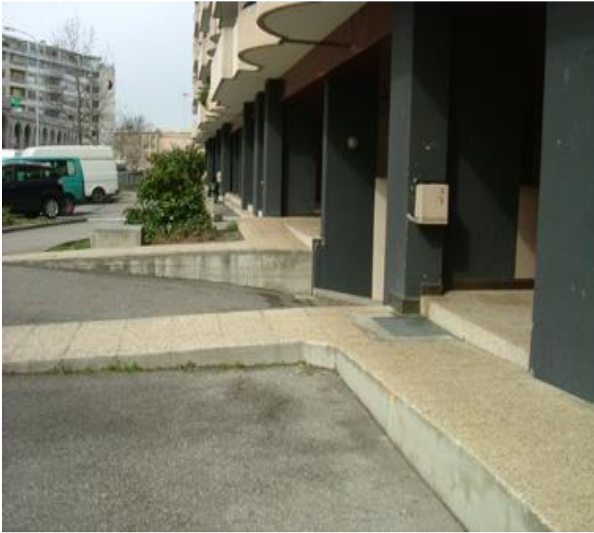
Chemin du Centurion : Rampes d'accès au parking souterrain qui empêchent la continuité du parcours piéton, au pied des immeubles
