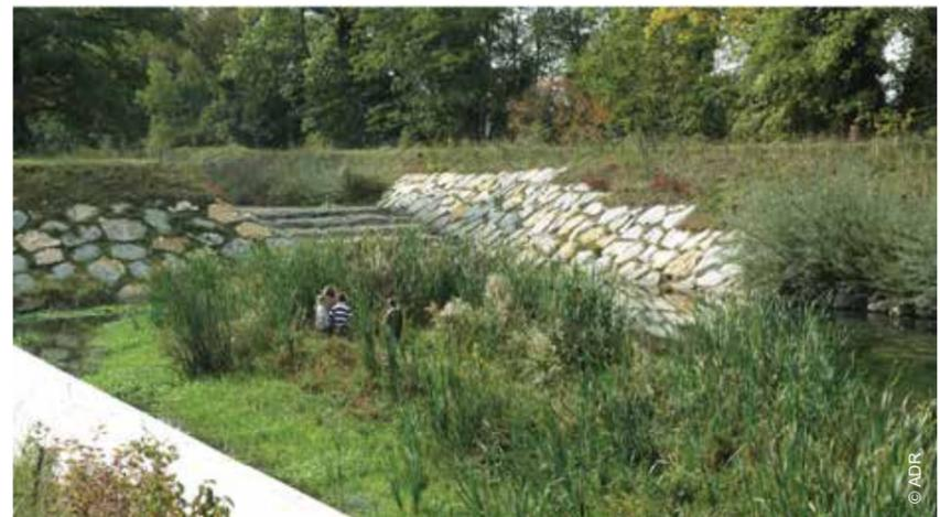
L'Aire est l'exutoire des eaux pluviales du quartier. L'intégration de bassins de rétention dans les Jardins de l'Aire, à proximité de la rivière, permet une gestion optimisée des rejets et la mise en place d'un réseau biologique en continuité avec le milieu naturel.
