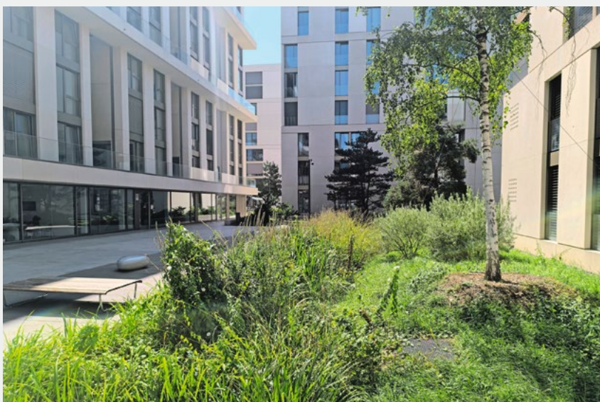
Fig. 3 Noue de rétention végétalisée au cœur du quartier de l'Adret, Ville de Lancy.
