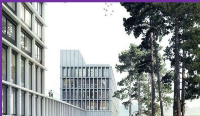
Nouveau bâtiment de la police internationale
