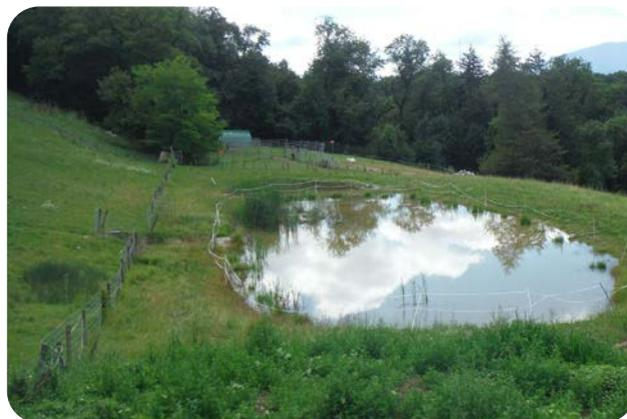
Pour ce deuxième cas concret, le volume de rétention est nettement plus grand, puisque le plan d'eau a une grande profondeur (1.70 mètre) pour une grande surface (400 m<sup>2</sup>).
