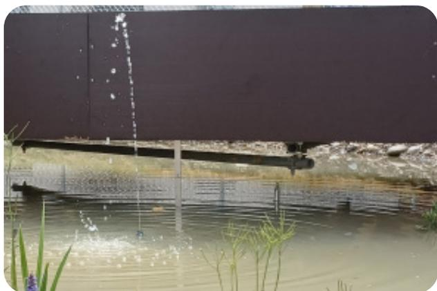
Même un petit jet d'eau solaire peut apporter des bénéfices... Celui-ci, d'une hauteur de 1 m et alimenté par une pompe solaire, permet de créer une onde sur l'eau, défavorable aux moustiques et aux grenouilles rieuses. De plus, le discret bruit de l'eau procure un sentiment de fraîcheur aux promeneurs. Une faible oxygénation de l'eau est aussi bénéfique à certaines espèces aquatiques exigeantes... Etang André Venturi, GE.
