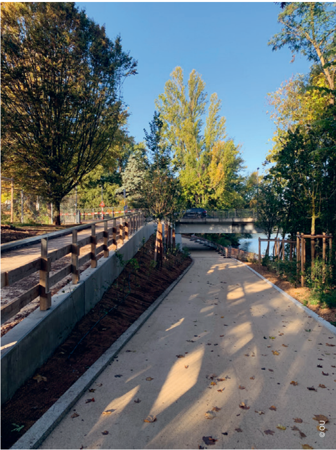
Nouvelle étape de la voie verte d'agglomération - Pont de la Fontenette à Carouge
