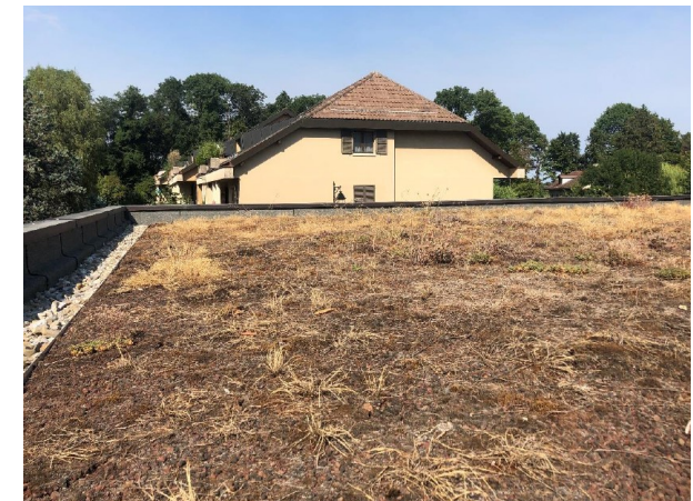
Photo de la toiture A (source: audit statique)
