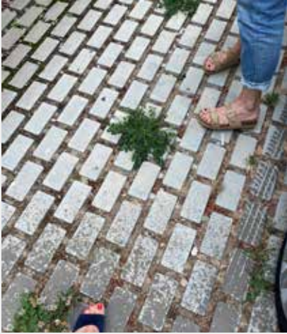
Une nouvelle palette de matériaux doit-être envisagé pour concilier permabilisation et viabilité, msv.
