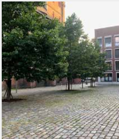
Perméabilisation des espaces publics carrossables à Hamburg, Altstadt, msv
