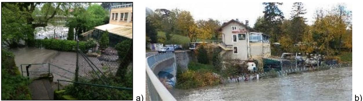
Figure 33 : Terrasse du restaurant – Pont de Sierne en 2015 (a). Le même restaurant en 2023 a été épargné à l'inondation grâce aux murs de protection et murs vitrés (b).
