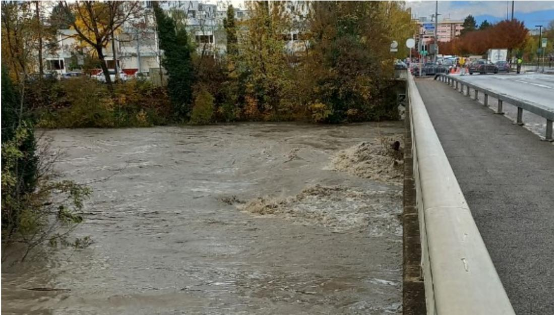
Figure 41 : Début d'embâcle observée au pont du Val-d'Arve
