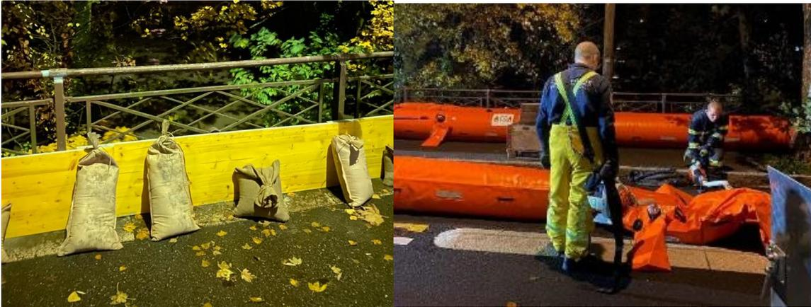
Figure 18 : Pose de protection contre les crues (Quai Ansermet), (à gauche sac de sable à droite boudins gonflables)
