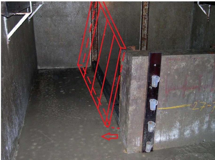
**Illustration n° 2: aspect positionnement clapet anti-retour**
