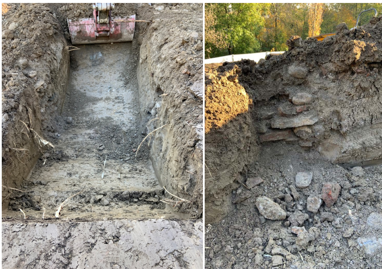
Figure 9 Sondage 2. A gauche, vue est-ouest, terre argileuse. A droite, détail de la tranchée de construction du muret.
