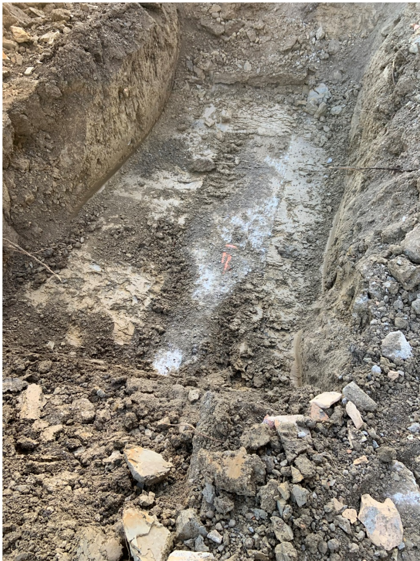
Figure 8 Sondage 1, vue ouest-est.
