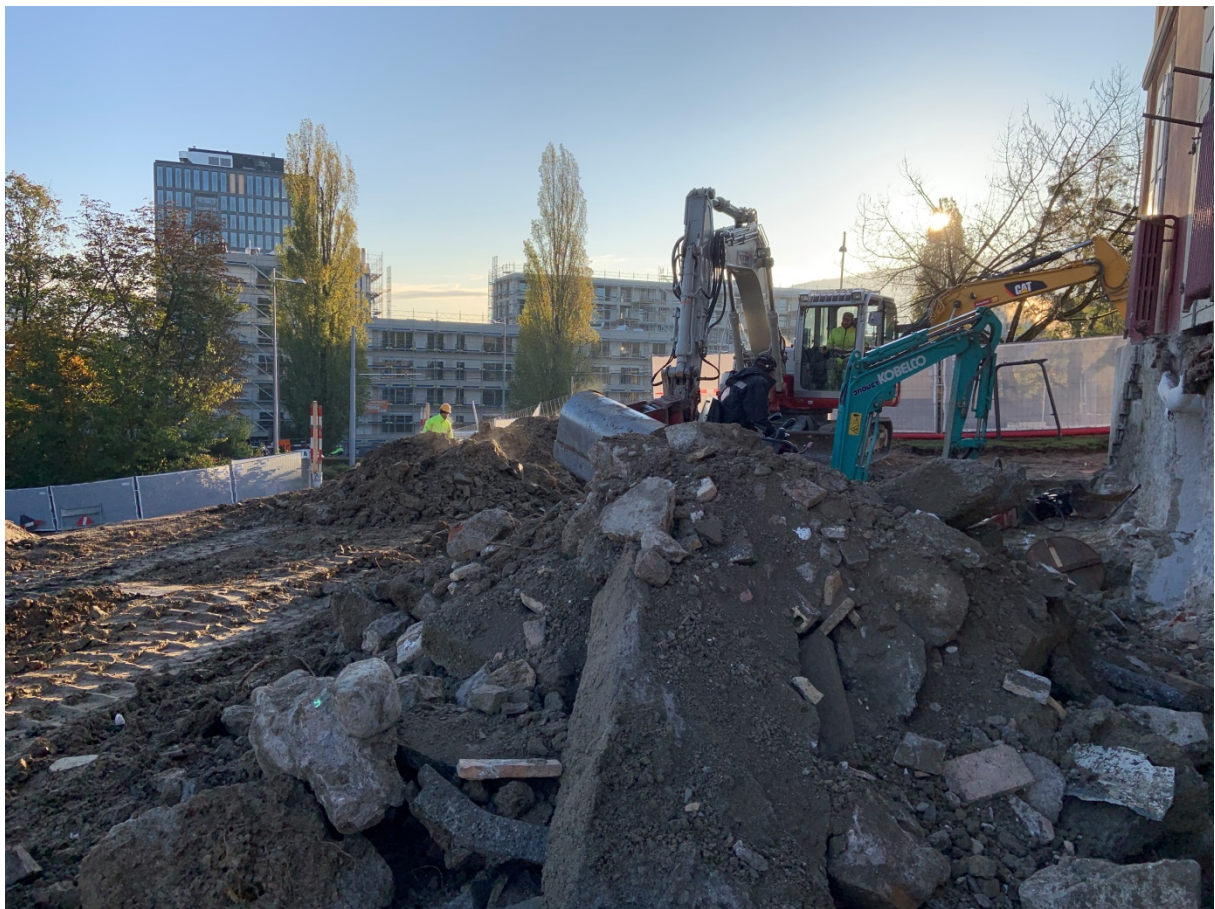
Figure 4 Vue des travaux en cours en direction de la Praille.
