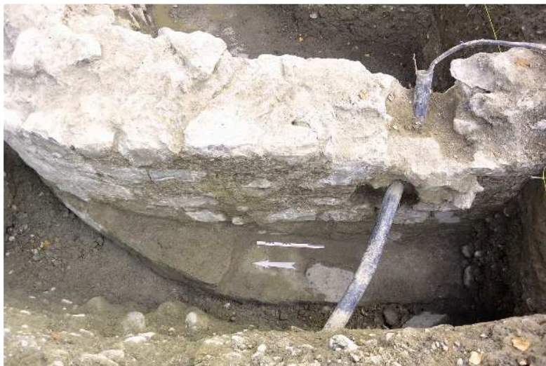
Figure 8 Face extérieure du tronçon 1 reposant sur une semelle de fondation (côté lac).
