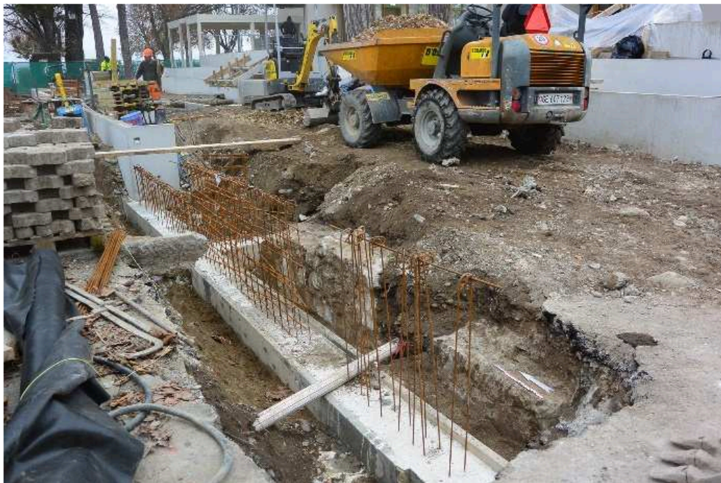
Figure 11 Tronçon 4 situé à l'extrémité sud de la propriété.
