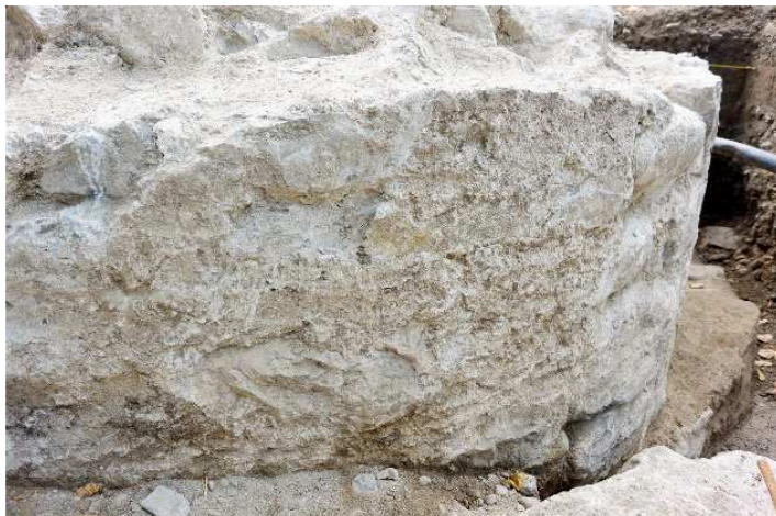
Fig. 6 Enduit couvrant la face extérieure (côté lac).
