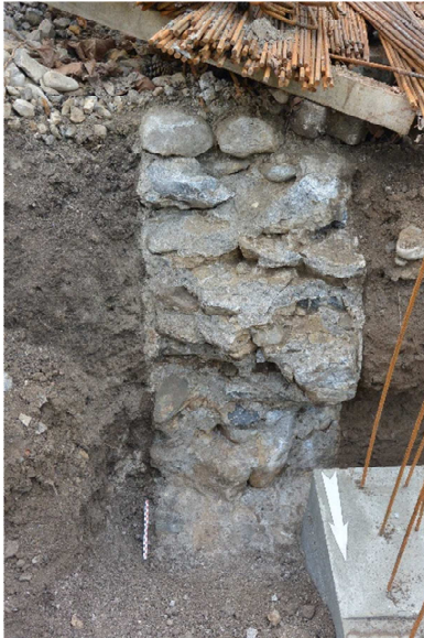
Fig. 9 Profil du tronçon 2 avec de l'enduit conservé de chaque côté.
