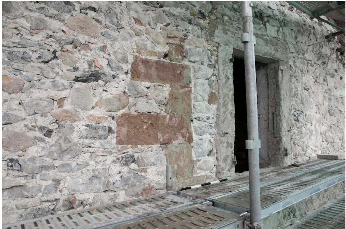
Figure 28. Maçonnerie en pierres de Meillerie, et encadrement en molasse d'une ancienne fenêtre.
