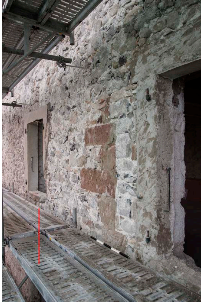
Figure 29. Le trait rouge indique la limite entre les deux maçonneries (fig. 23 II et V).
