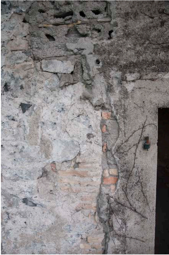
Figure 33. Chaînage d'angle remplacé par des briques.
