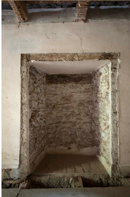
Figure 22. Percement dans le mur mitoyen.
