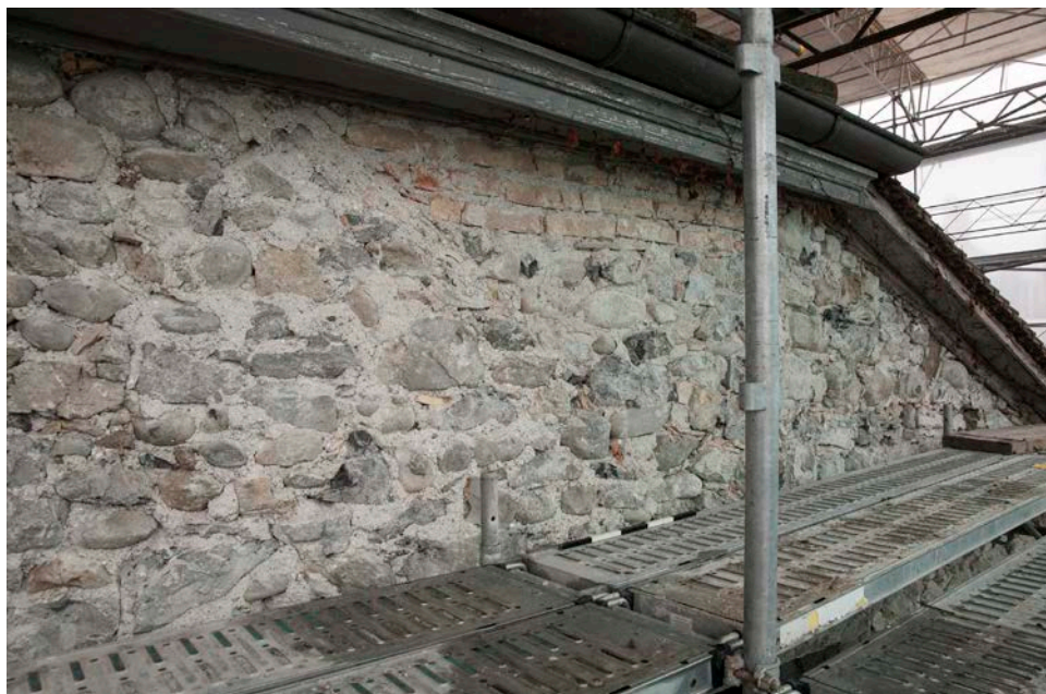
Figure 32. A droite, la surélévation du toit.
