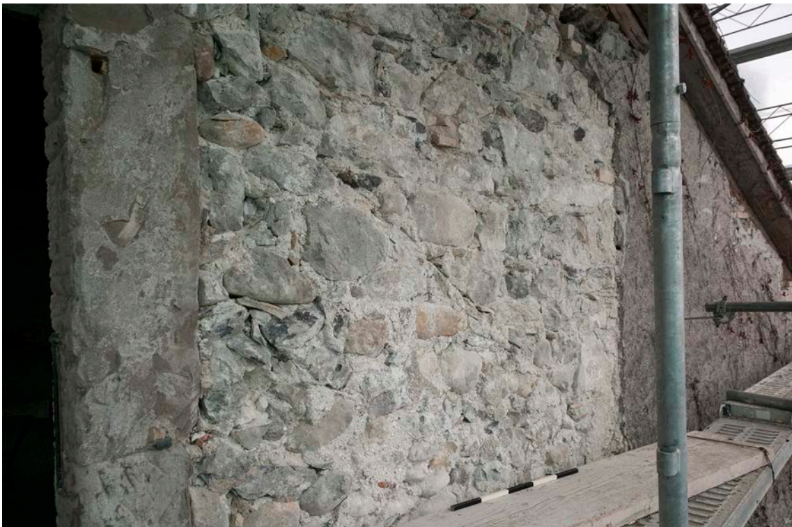
Figure 30. Sommet du mur pignon coupé par une fenêtre (à gauche).
