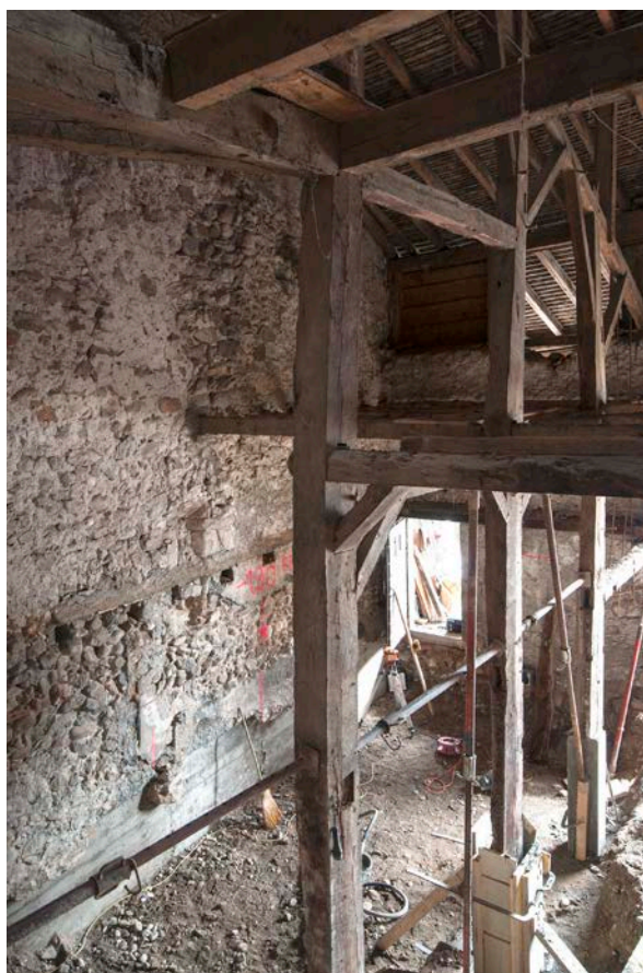
Figure 14. Charpente ancrée dans le mur.
