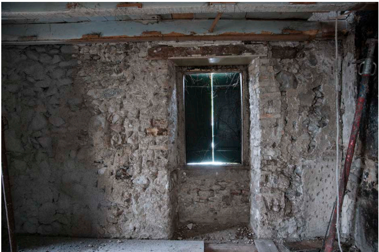
Figure 17. Mur nord, premier étage. L'importante reprise liée au percement et à l'aménagement de la fenêtre est bien marquée. A gauche de la fenêtre, une petite ouverture est coupée par la reprise et condamnée.
