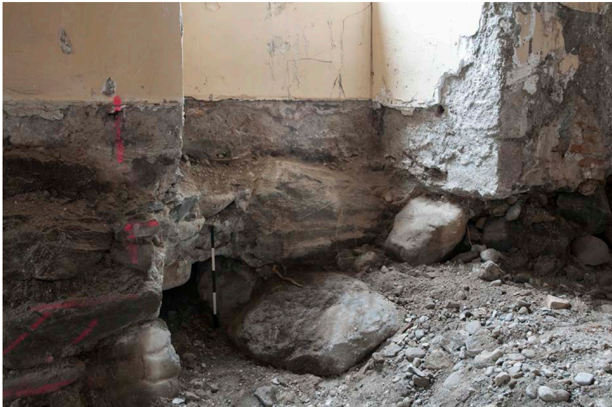
Figure 15. Pierres de dimensions importantes marquant l'angle de la fondation du mur.
