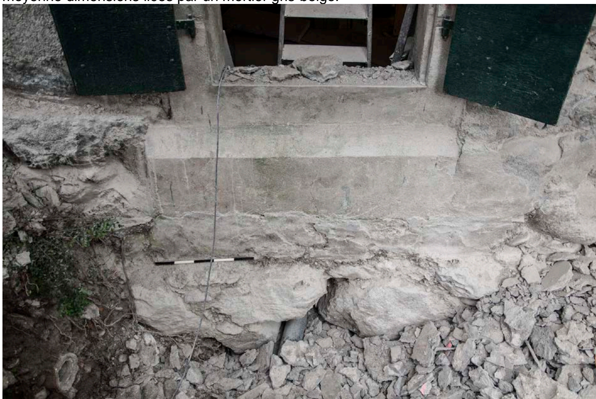
Figure 14. Fondation de la moitié nord du mur de façade (M3).
