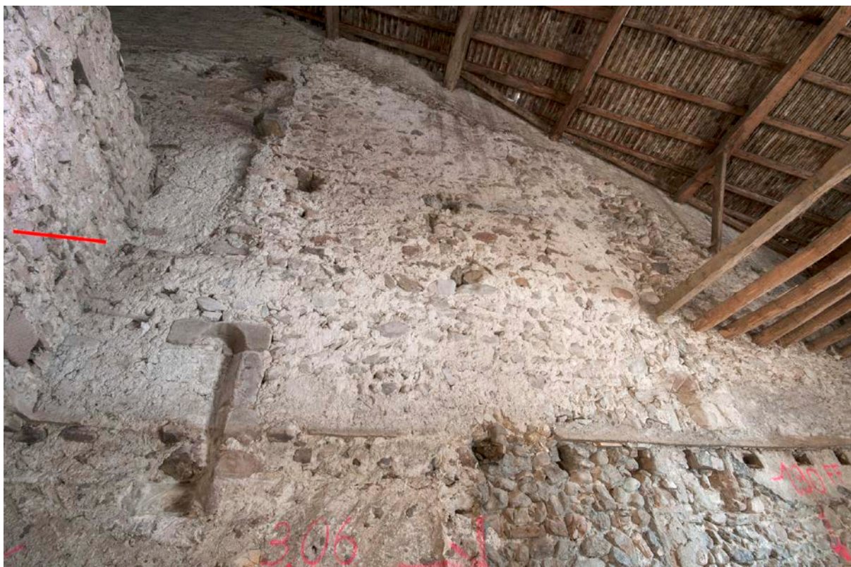
Figure 10. Mur mitoyen. La limite de la maçonnerie se distingue aisément dans le prolongement du trait rouge.
