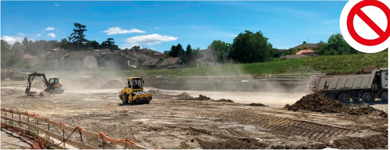
Absence de mesures pour limiter les émissions de poussières (chantier non conforme).
