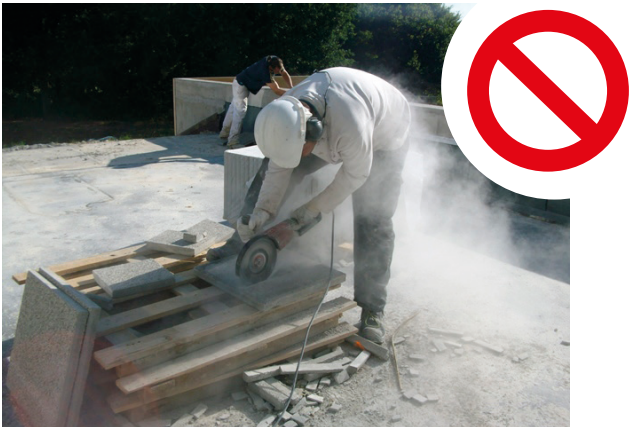
Figure 1 DÉCOUPE NON-CONFORME :
