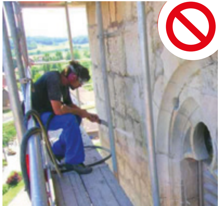
Figure 2 SABLAGE NON-CONFORME :
