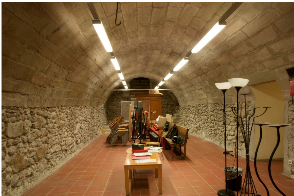
Figure 38. Vue de la cave dans sa longueur, vers l'ouest. Les irrégularités de l'assise de la voûte sur les murs nord et sud sont manifestes.
