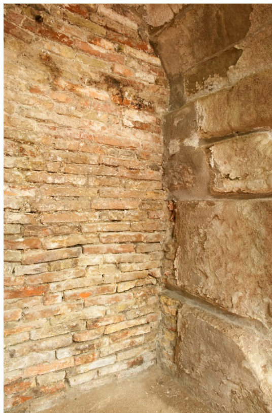
Figure 16. Appareil en brique B 4 bouchant l'ouverture B 3 et entailles dans les joints des blocs de molasse, pour insérer des rayonnages.
