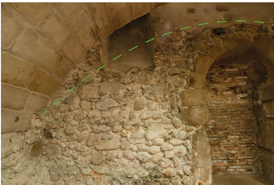
Figure 18. Restitution hypothétique du profil de la voûte d'origine.
