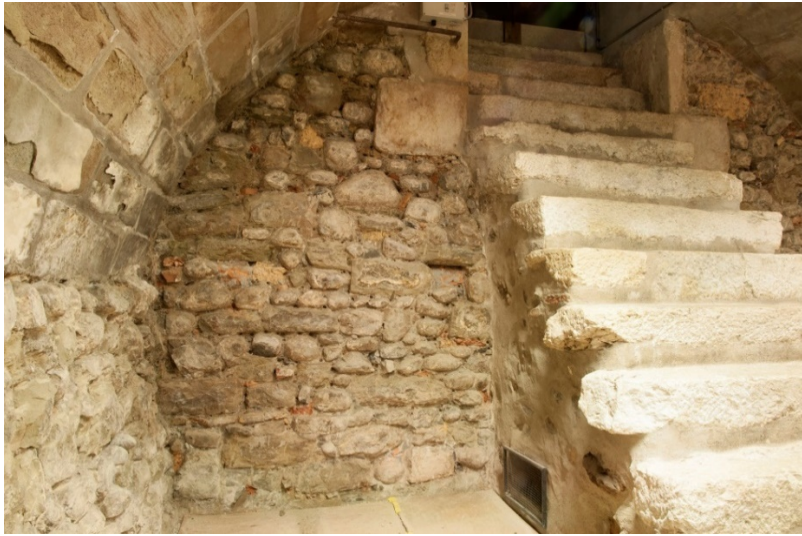
Figure 34. Vue sur la moitié sud du mur M 13.
