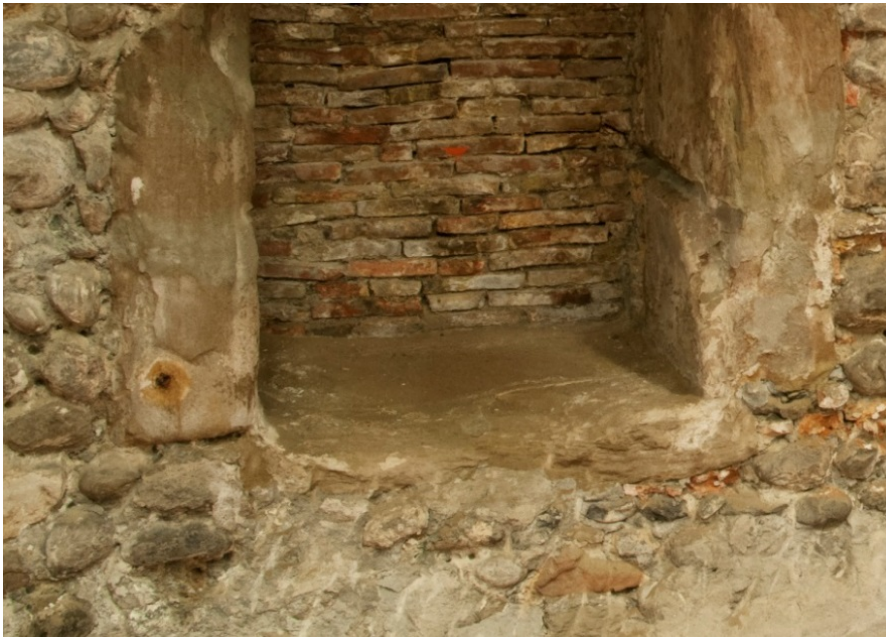
Figure 17. Seuil en molasse de l'ouverture B 3, montrant des traces d'usure.
