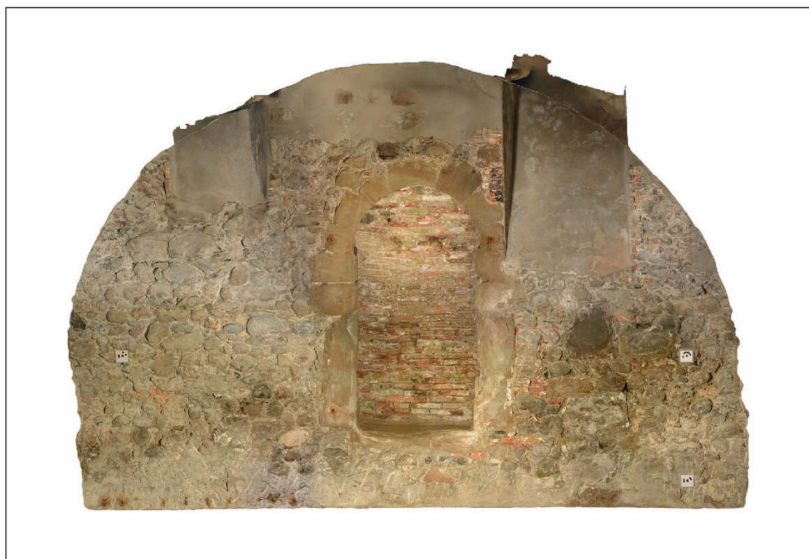
Figure 14. Relevé schématique du mur M1 avec ses différentes unités stratigraphiques (en haut) et orthophotographie issue du modèle photogrammétrique (en bas).
