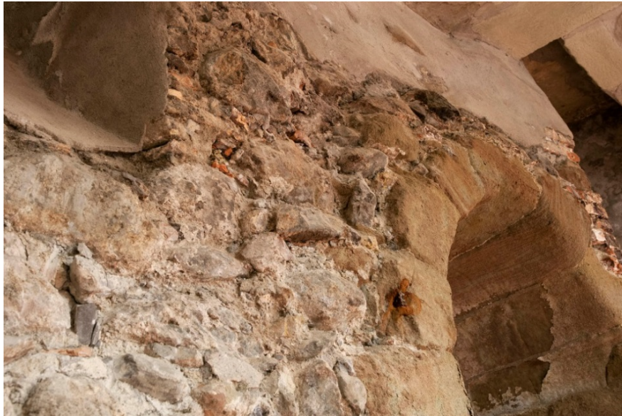
Figure 15. Reprise US 9 du mur M 1, en léger retrait par rapport à l'appareil d'origine.
