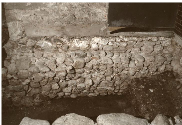
Figure 10. Mur de fondation de l'église luthérienne.
