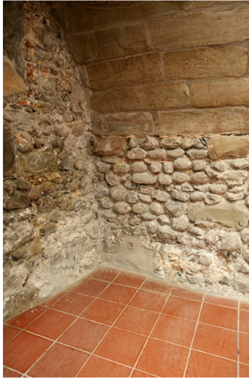
Figure 24. Mur M 11, extrémité orientale. La moitié inférieure de la maçonnerie présente un appareil distinct (US 14).
