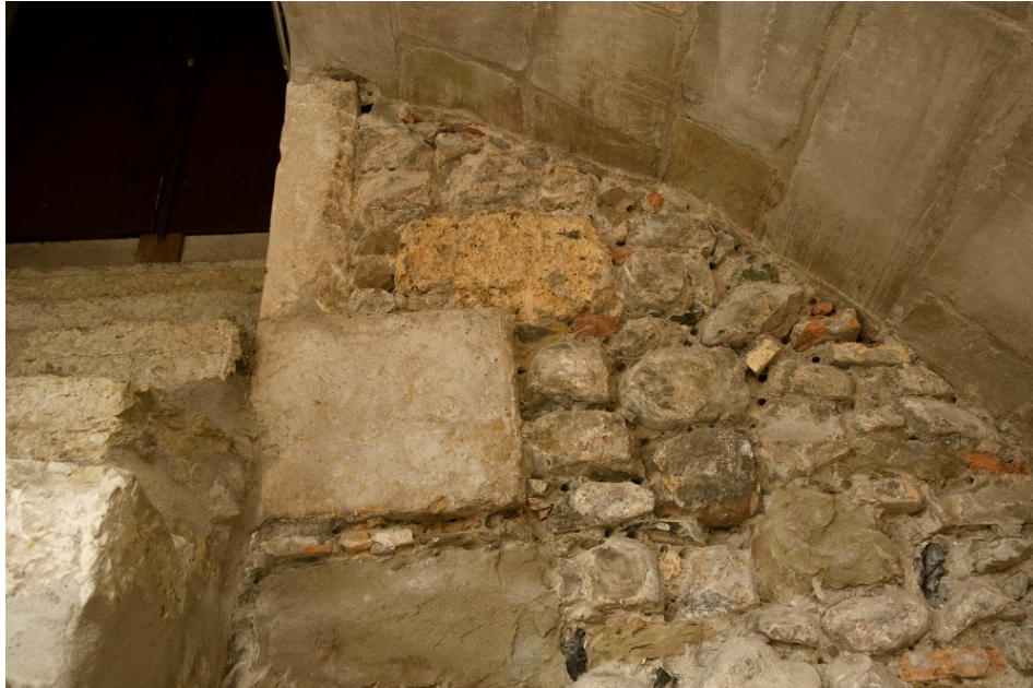
Figure 37. Mur M 13. Vue sur la moitié nord de l'US 23, avec l'encadrement de la porte B 24 et la jointure entre le mur et la voûte B 21.
