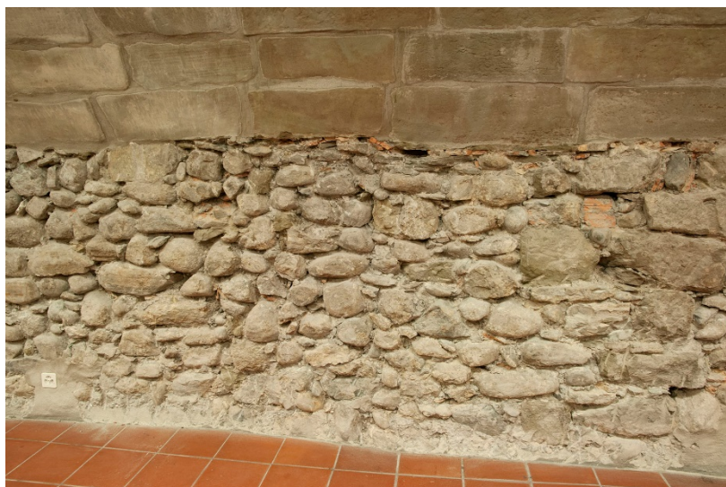
Figure 28. Mur M 12. Vue sur les maçonneries US 36, US 18 et US 19.
