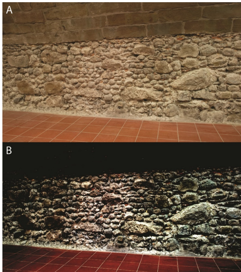
Figure 25. Mur M11. L'US 26 se remarque surtout grâce à sa limite est (A). Un traitement des niveaux colorimétriques sous Photoshop fait nettement ressortir le blanc de son mortier (B).
