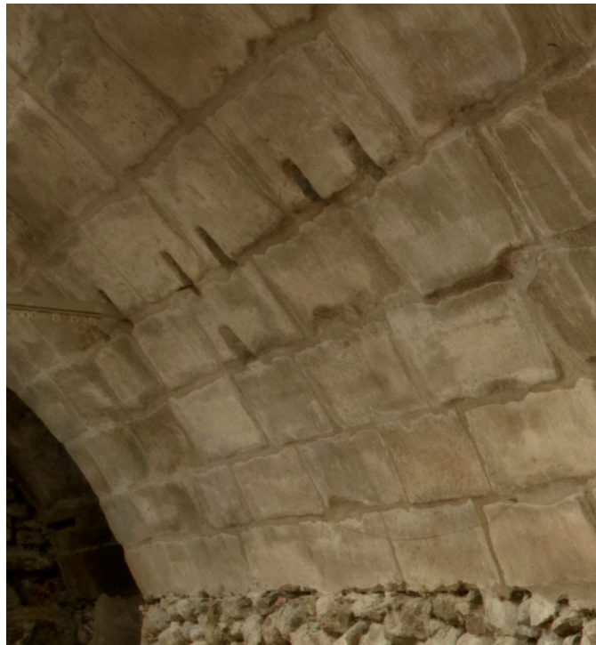
Figure 39. Les entailles dans le versant nord de la voûte.
