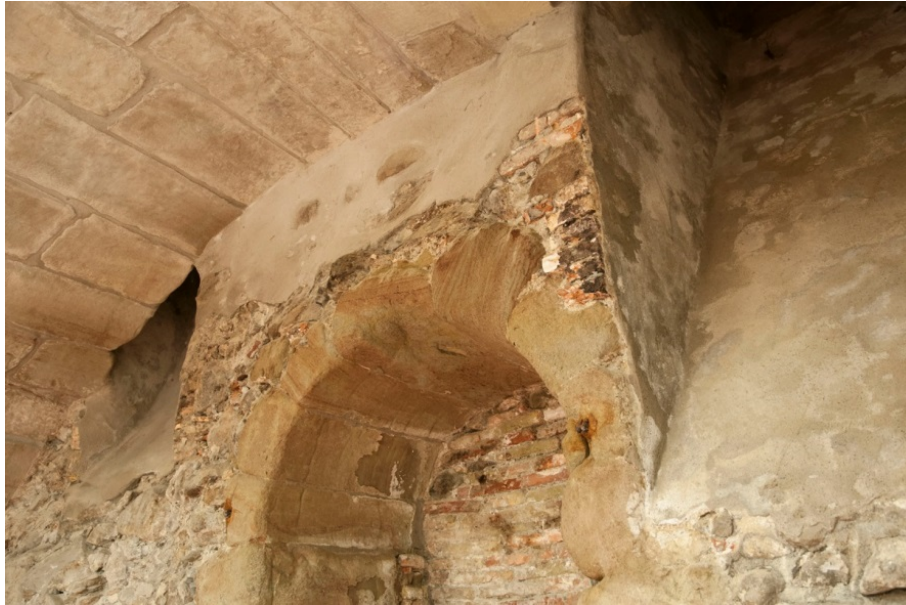
Figure 19. Conduit d'aération B 5 et son montant en brique US 7. Le bas du conduit a été aménagé en taillant la molasse de l'ouverture B 3.
