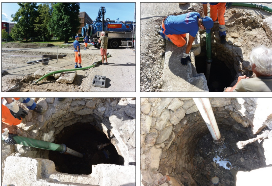
Fig. 11 - Intervention de l'entreprise Hominal : vidange des sédiments par aspiration.
