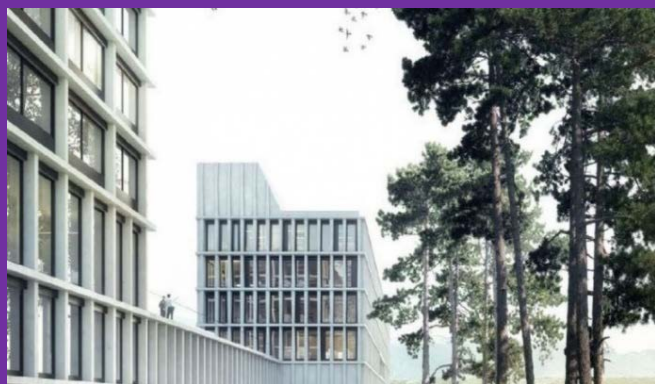
Nouveau bâtiment de la police internationale
