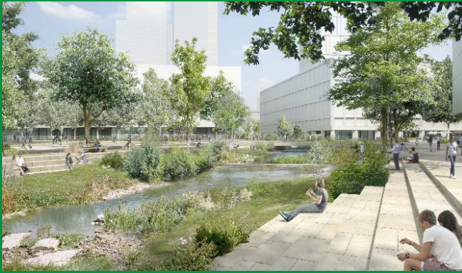
Renaturation de l'Aire et de la Drize dans le secteur du PAV
