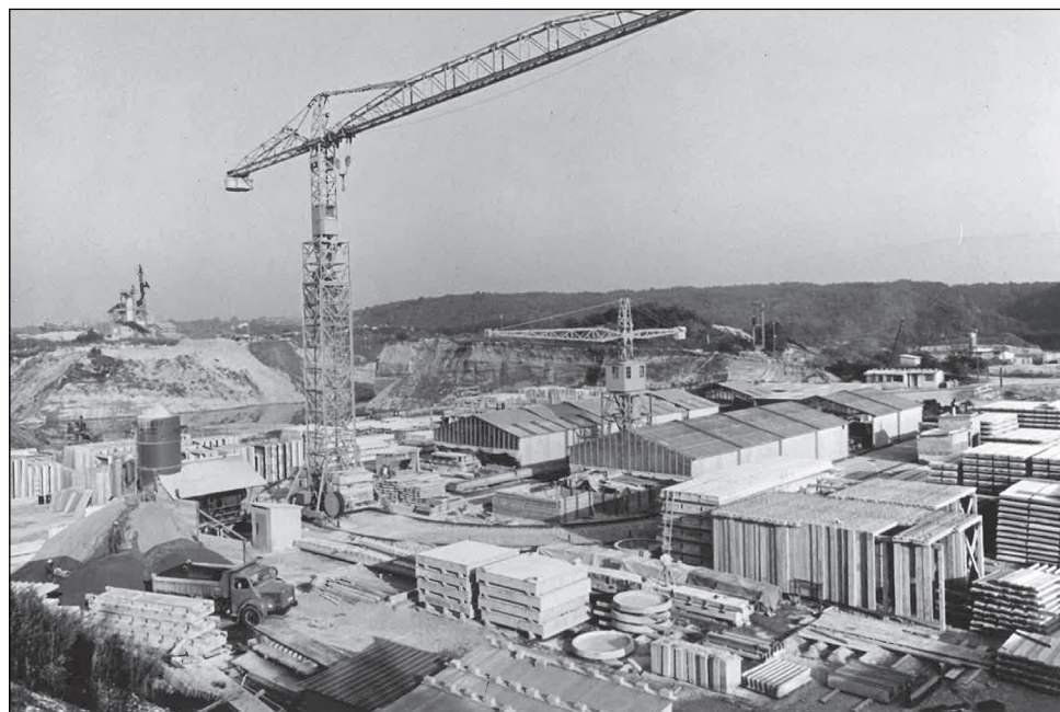
Fig. 01 : Usine de préfabrication du Bois de Bay, à Satigny, 1968.
