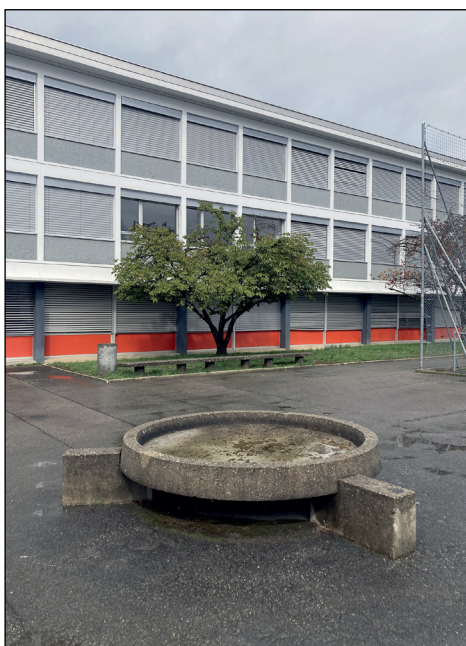
Fig. 13 : Mobilier extérieur dessiné par l'architecte (fontaine et banc en béton), 2022.
