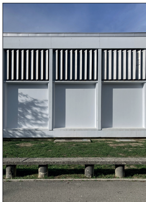
Fig. 14 : Détail des façades préfabriquées en béton des salles de gymnastique, 2022.
