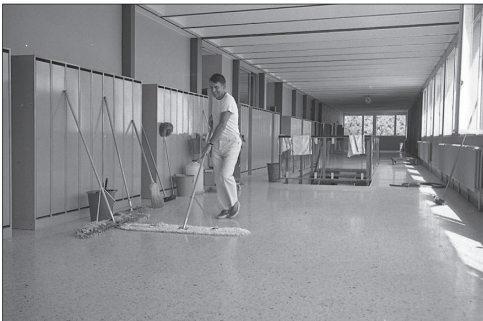
Fig. 09: Vue intérieure du bâtiment de liaison, 1969.
