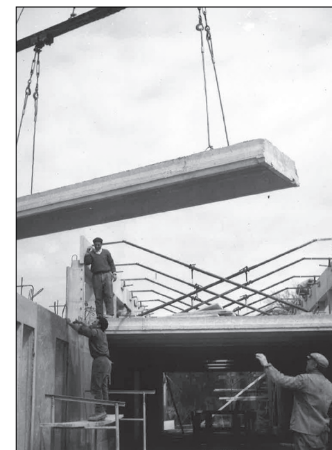
Fig. 05 : Montage des dalles de plancher nervurées venant s'appuyer sur les murs de refend des salles de classe.
