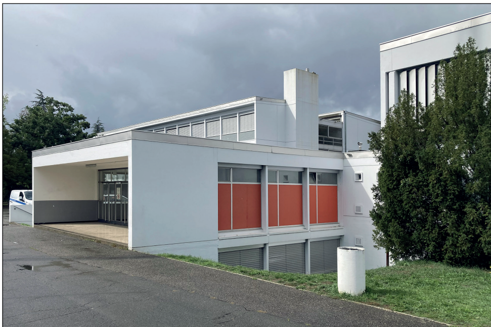
Fig. 12 : Entrée principale de l'établissement, 2022.
