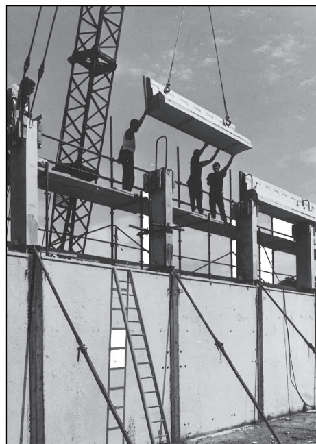
Fig. 04 : Construction d'une salle de gymnastique : pose des linteaux et des dalles de couverture.
