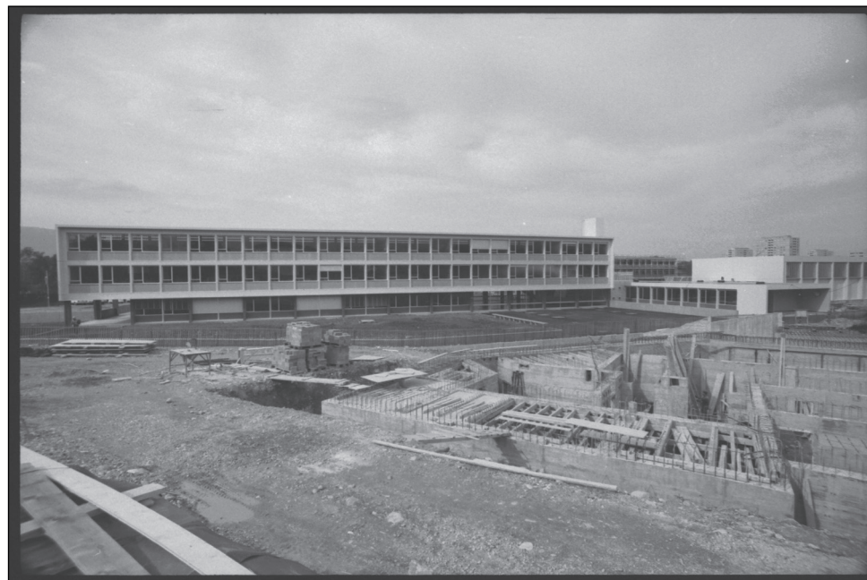
Fig. 06 : Le cycle d'orientation du Marais terminé, 24 mars 1967.
