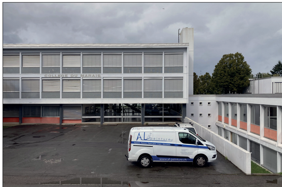
Fig. 11: Vue des bâtiments depuis le parking, 2022.
