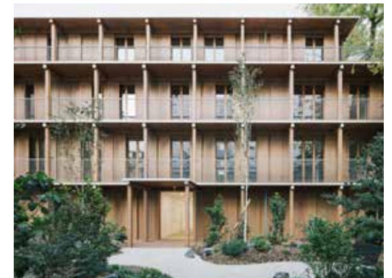
73 logements, Mars Architectes, Paris
