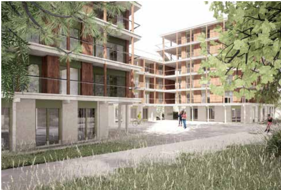
LOV_CODHA (en cours) Projet logements coopératif Construction mixte bois-béton
