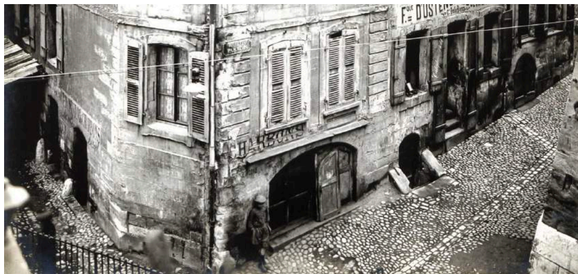
Fig. 11 Rue du Paradis (aujourd'hui disparue, cette rue était vers le temple de la Madeleine) en galets avec caniveau central.
