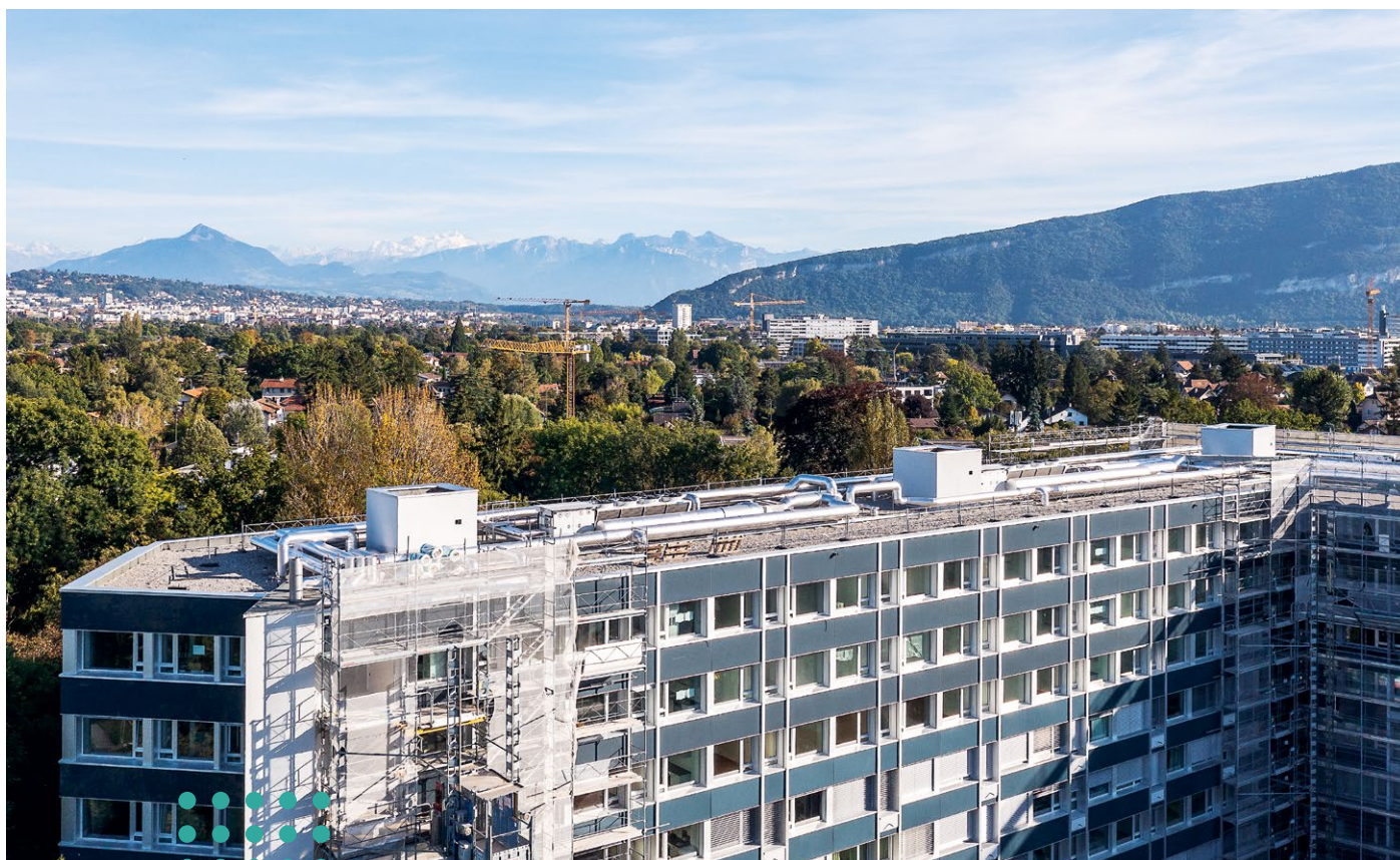
Cet ensemble résidentiel de 260 logements à Chêne-Bougeries est alimenté par sept pompes à chaleur air-eau qui fournissent environ 90% de l'énergie thermique.
