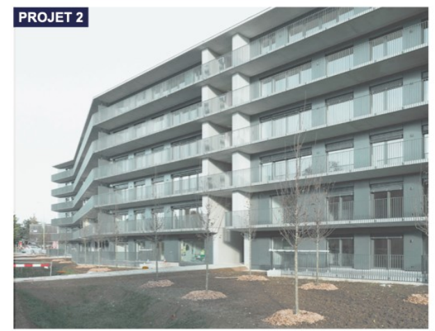
Immeuble de 77 logements, commune de Thônex
