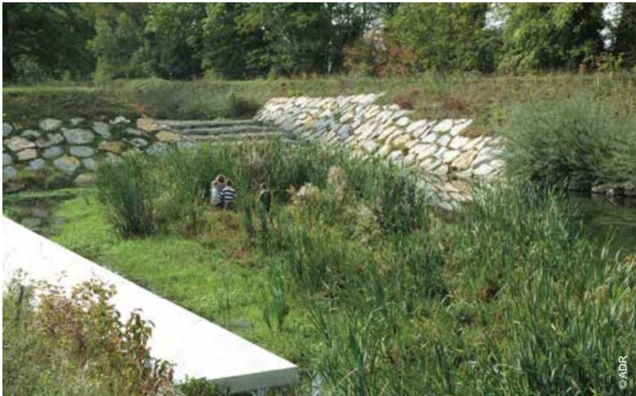
L'Aire constitue l'exutoire des eaux pluviales du quartier. L'intégration de bassins de rétention dans les Jardins de l'Aire, à proximité immédiate de la rivière, permet une gestion optimisée des rejets et la mise en place d'un réseau biologique en continuité avec le milieu naturel.
