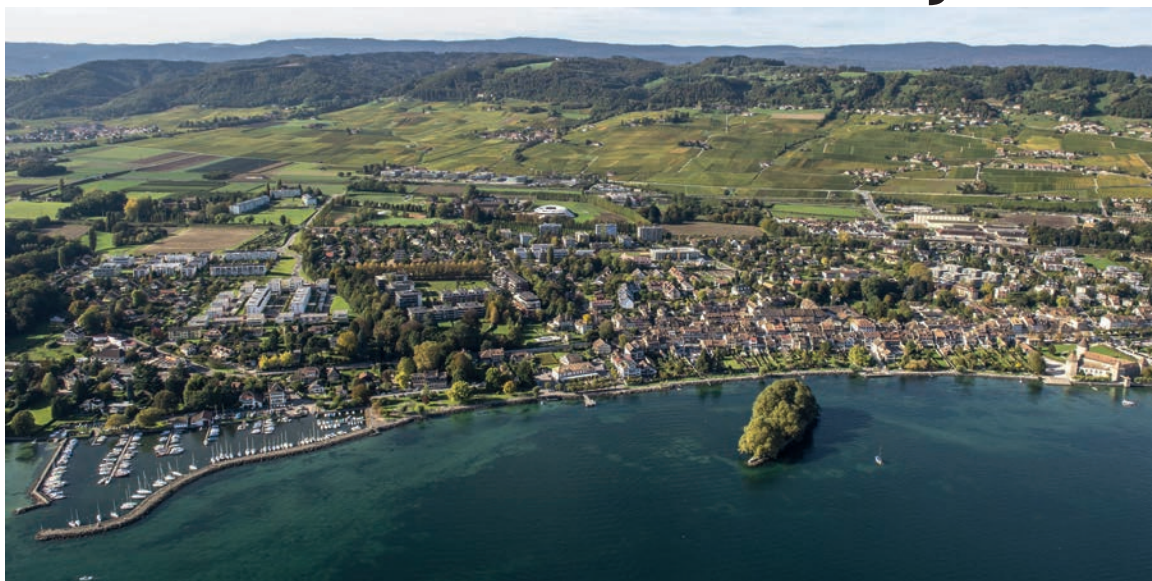
Seules les communes n'auraient pu réaliser des projets d'envergure comme les interfaces multimodales ou le réaménagement de la Route suisse. Photo Jean REVILLARD
