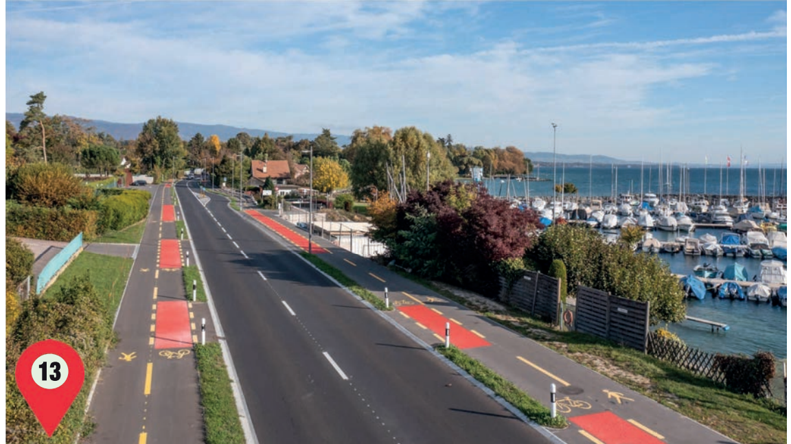
La Route suisse bénéficie d'une requalification pour gérer le flux automobile mais aussi pour aménager des espaces pour la mobilité douce. Photo Swiss-Fly Boris Bron
