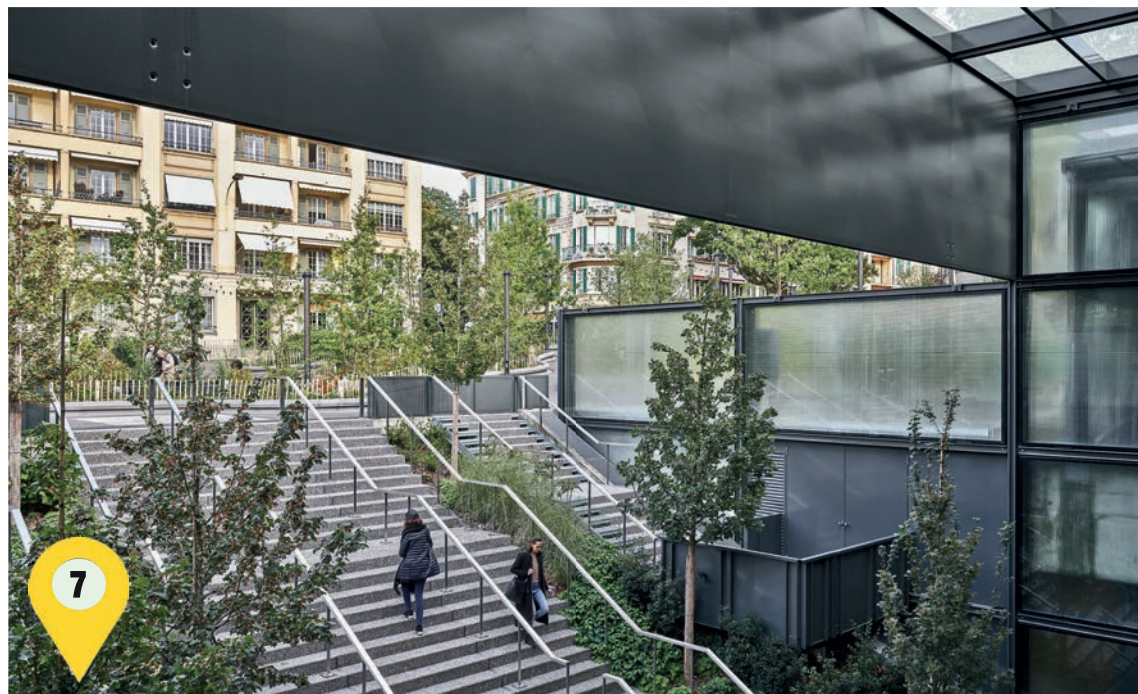
Les pôles d'échanges multimodaux du Léman express font partie des réalisations financées par le Projet d'agglomération. Ici, la gare de Genève-Champel. Photo Serge FRUEHAUF
