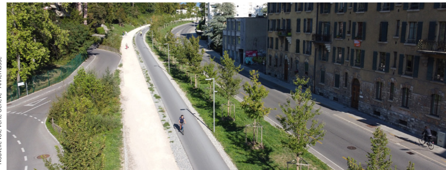
Nouvelle voie verte Genève - Annemasse
