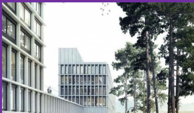
Nouveau bâtiment de la police internationale
