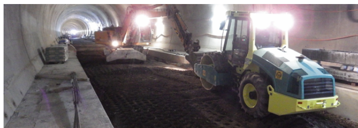
Remblayage du tunnel
