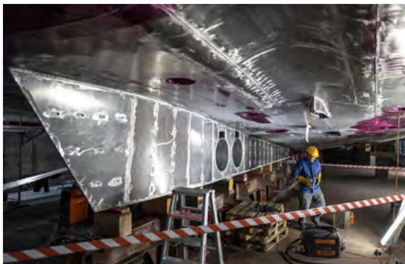
La construction du Naviexpress qui reliera Evian à Lausanne en 2023.
