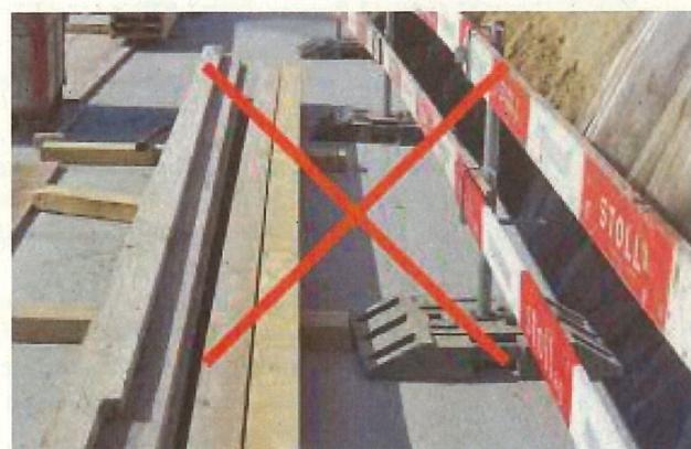
6 Il est interdit de placer un socle en caoutchouc au bord de la dalle car le garde-corps périphérique peut basculer.
