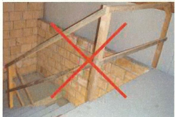
2 L'utilisation de lattes de toit comme main courante dans une cage d'escalier est interdite.
