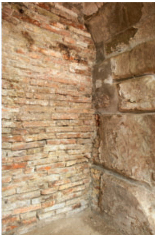
11 Appareil en brique bouchant l'ouverture (B 3) et entailles dans les joints des blocs de molasse, probablement pour insérer des rayonnages.
