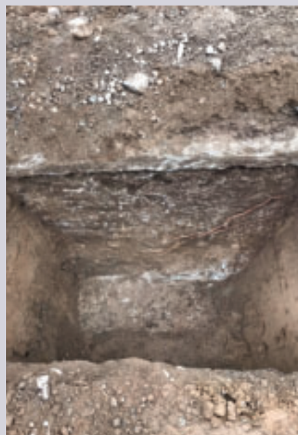
23 Tronçon 3 recouvert par une dalle de couverture. Photo SAGE, A. de Weck.
