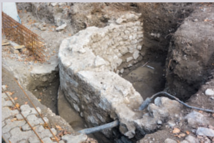
21 Angle du mur côté lac, reposant sur une probable semelle de fondation. Photo SAGE, A. de Weck.
