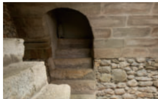
16 Mur nord M 12. Vue du passage B 20.
