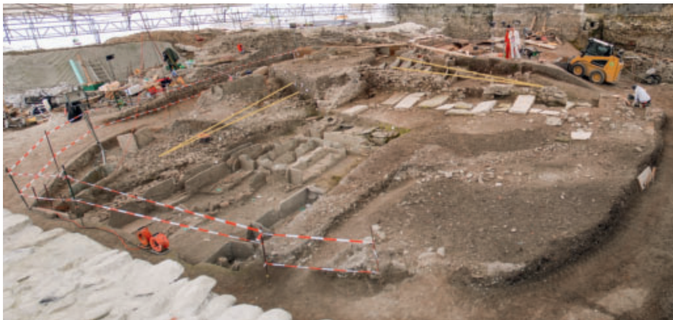
4 Vue générale du chantier depuis le nord-est en juin 2013. Les traits jaunes indiquent les deux pentes observées sur le site.
